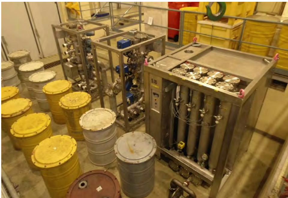
Abbildung 3-5: Vorbereitung der Behandlung von Komponenten von Reststoffen nach Entnahme aus 20-ft-Frachtcontainer
