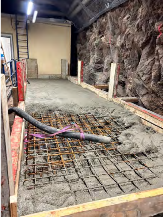
Abbildung 3-2: Errichtung eines neuen Betonfundamentes im Felsenkeller
