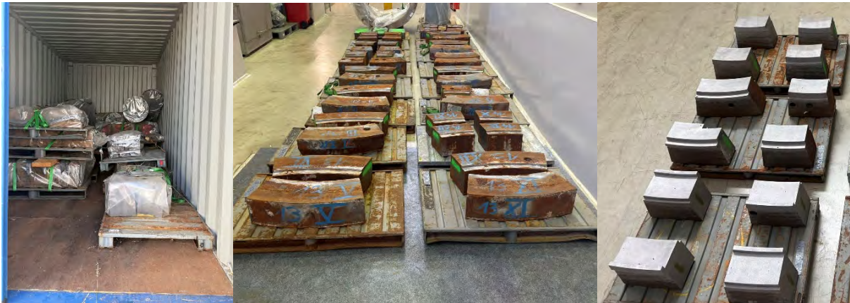
Abbildung 3-3: Entnahme von Gussringteilen und weiteren Großkomponenten des RFR aus einem 20-ft-Großcontainer vom Betriebshof der ESR, radiologische Bewertung, Zerlegung, Dekontamination und Vorbereitung zur Freigabe
