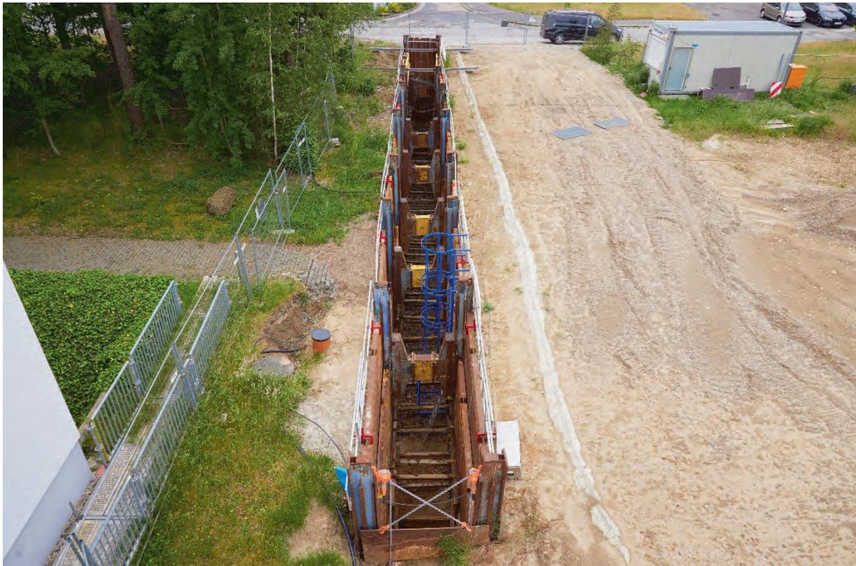
Abbildung 3-1: Gleitschienenverbau im Rückbaubereich
