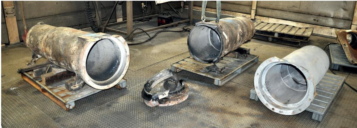
Abbildung 3-2: Demontage und Zerlegung von RFR-Komponenten als Vorbereitung für die Einschmelzkampagne
