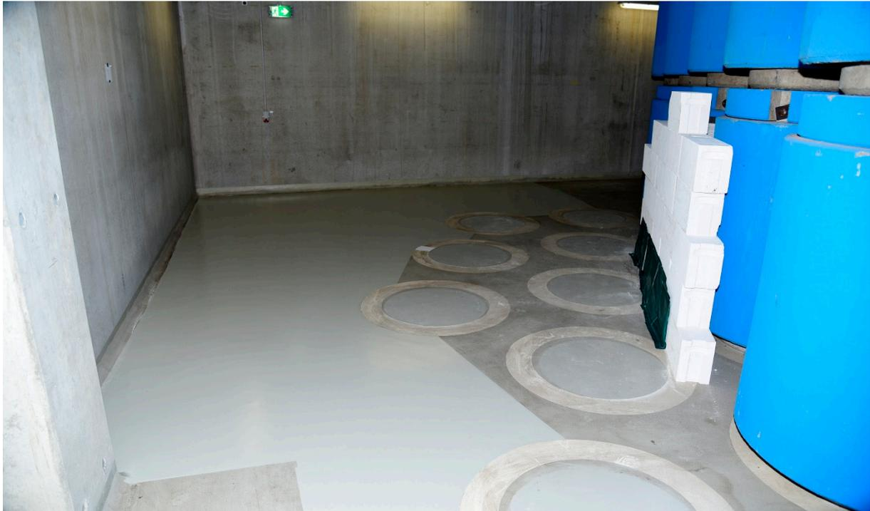
Abbildung 3-2: Exemplarische Darstellung der sanierten Fußbodenflächen im ZLR
