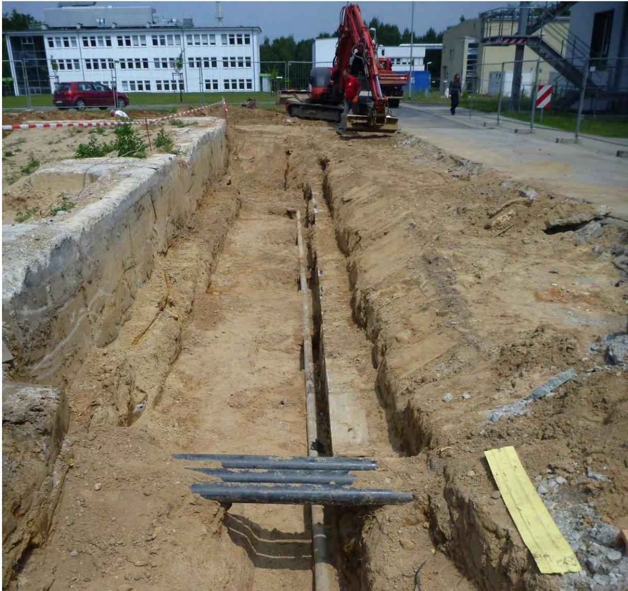
Abbildung 3-4: Baugrube für den Rückbau der Rohrleitung RS 53
