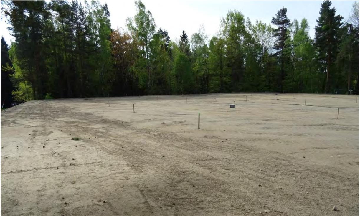
Abbildung 3-2: Baufeld vor Endprofilierung und Oberflächenabdeckung
