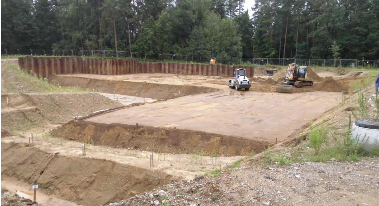
Abbildung 3-2: Planieren und Verdichten des in der Baugrube des ehemaligen Reaktorgebäudes verfüllten Erdreichs
