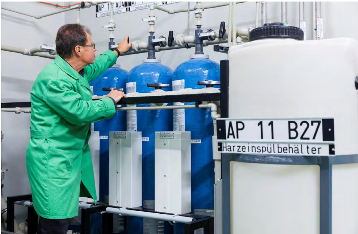
Abbildung 3-6: Harzsäulen der Ionenaustauscheranlage
