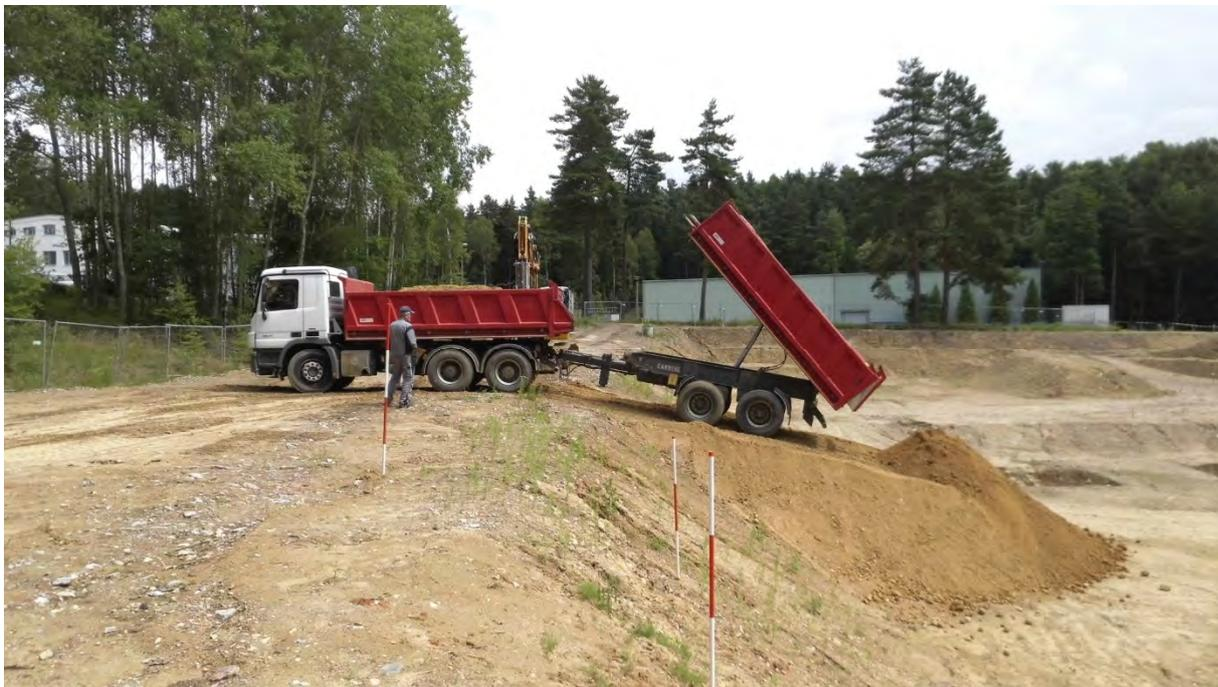
Abbildung 3-1: Anlegen der Zufahrt zur Baugrube des ehemaligen Gebäudes 790
