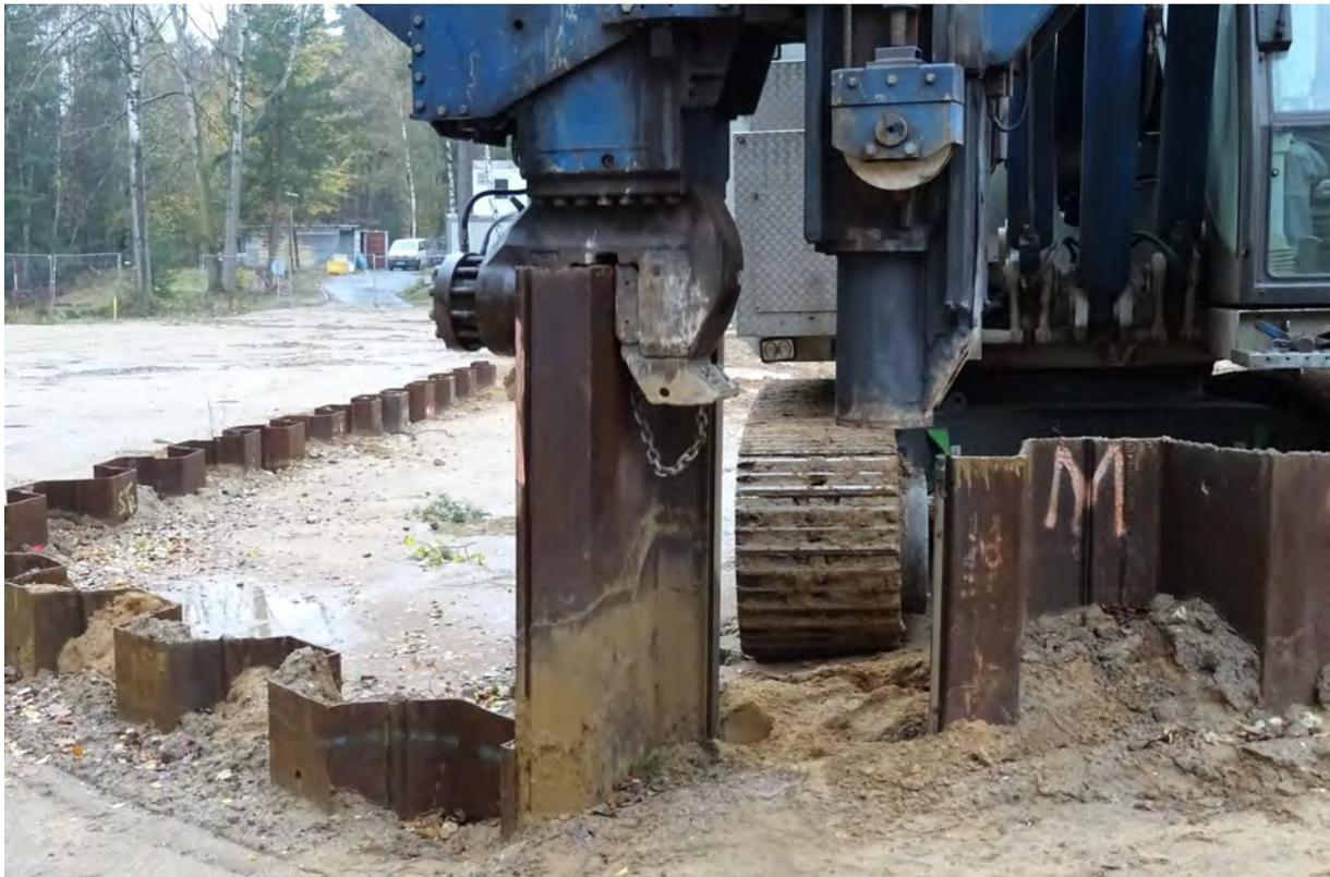
Abbildung 3-3: Ziehen einer Spundbohle
