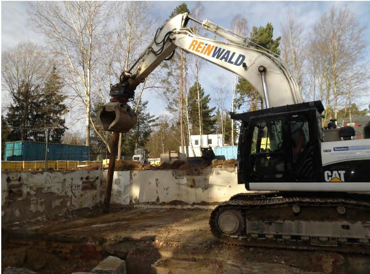
Abbildung 4-2: Herausziehen des Metallrohres vom Quellenlager
