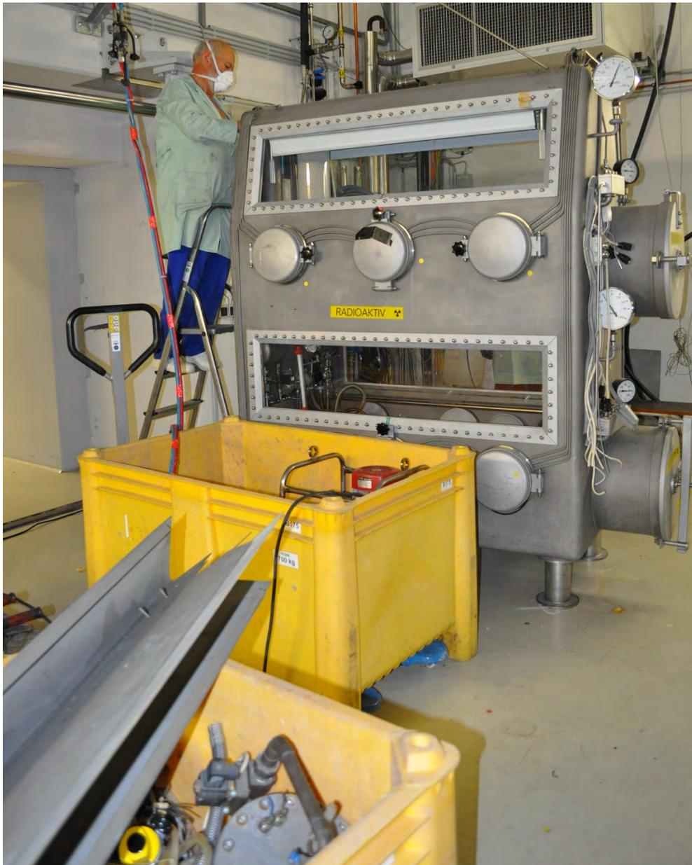
Abbildung 4-7: Demontagarbeiten an einer tritiumkontaminierten Glovebox im Gebäude 540
