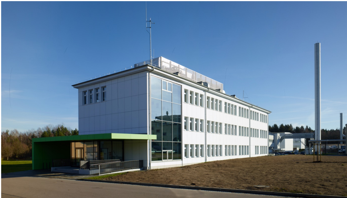
Abb. 4-11 Neues Strahlenschutzgebäude, Blick von Norden (Stand 10/2015)
