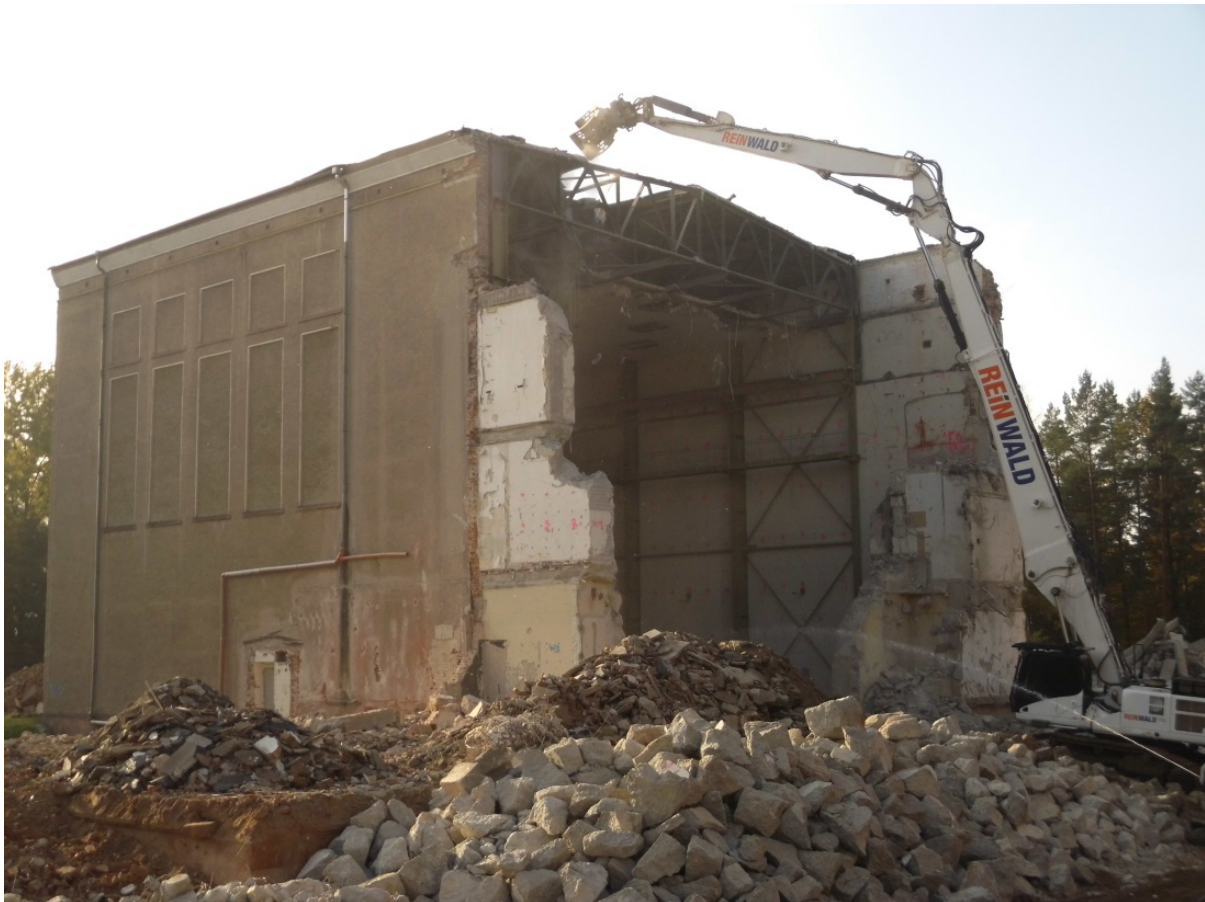
Abb. 4-4 Abriss der Reaktorhalle des Rossendorfer Forschungsreaktors
