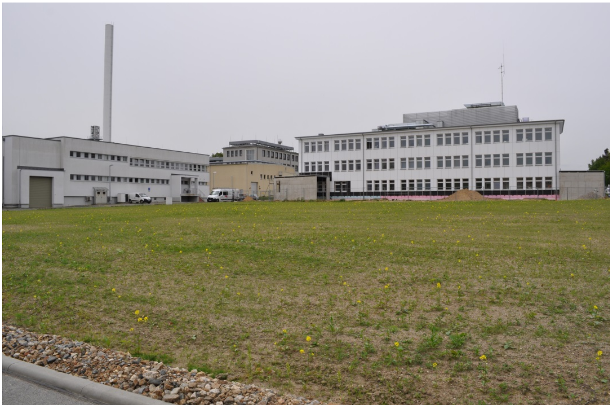
Abb. 4-5 Abbruchbereich III im Mai 2015 als „Grüne Wiese“ (rechts im Hintergrund angrenzend das Gebäude 890 als neue Strahlenschutzzentrale des VKTA)
