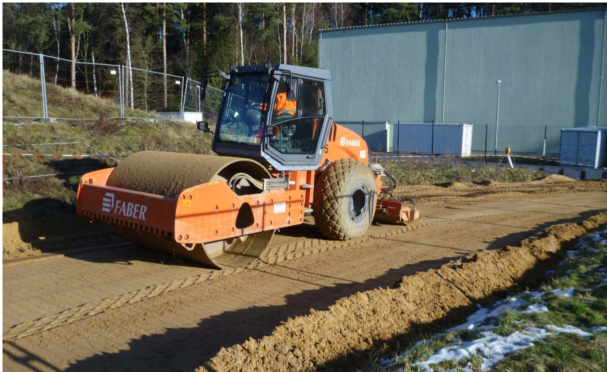
Abb. 4-6 Errichtung der Baustraße im Freigelände
