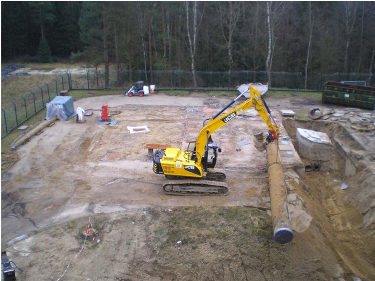
Abb. 4-2 Herausheben eines Teilstückes eines Abluftkanals
