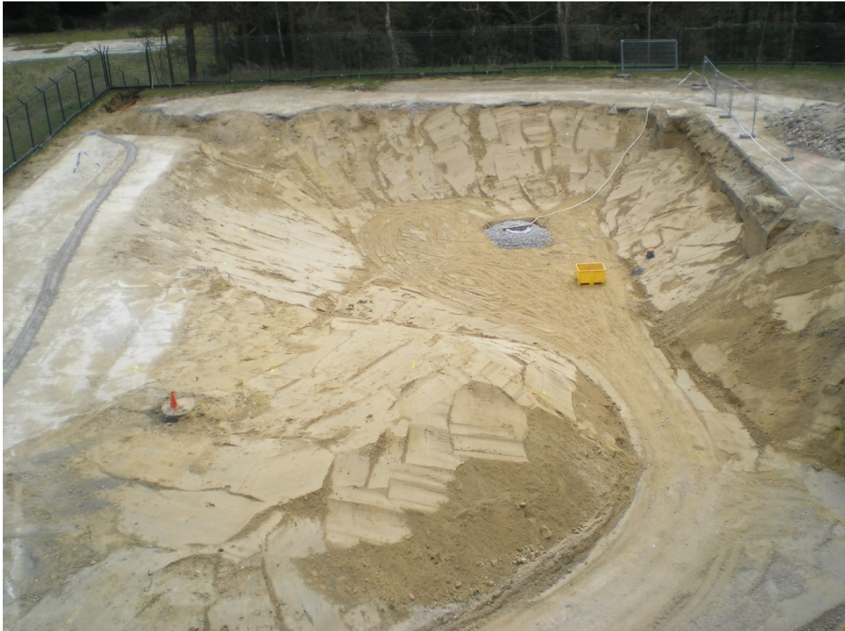
Abb. 4-3 Baugrube vom ehemaligen Gebäude 791
