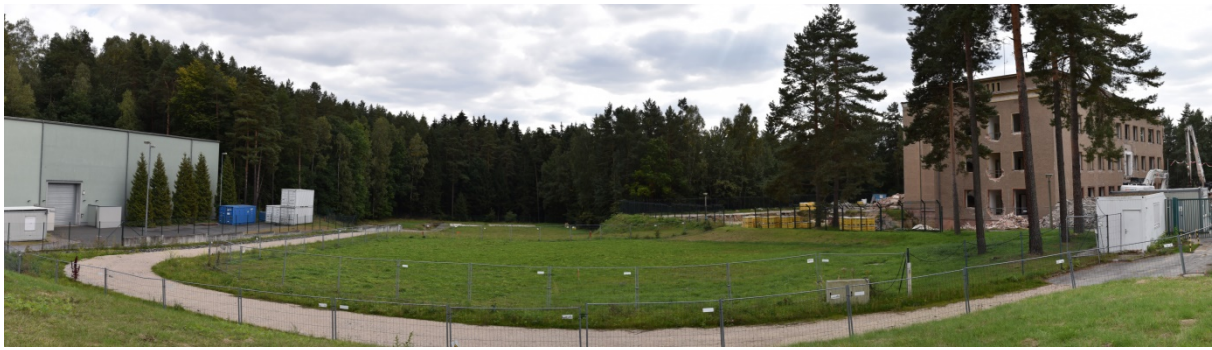
Abb. 4-7 Teilverfülltes Freigelände mit der neu errichteten Baustraße
