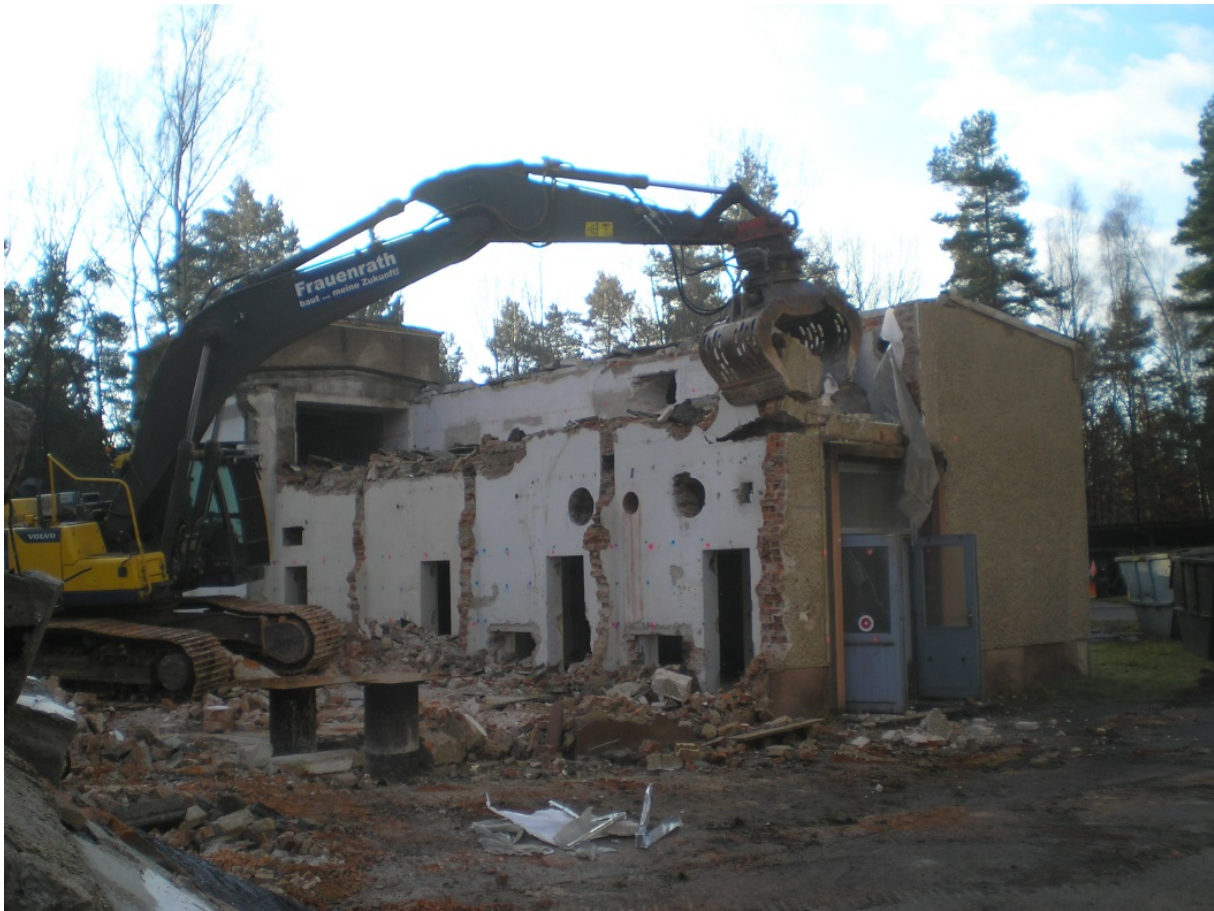
Abb. 4-2 Abriss des Ventilationshauses
