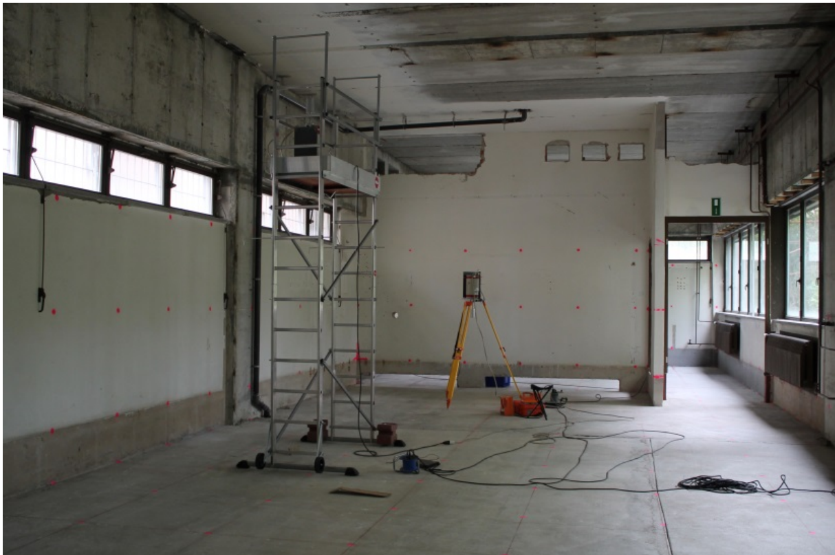
Abb. 4-14 Messung mittels unkolimierter ISG in der ehemaligen Warte des Reaktorgebäudes
