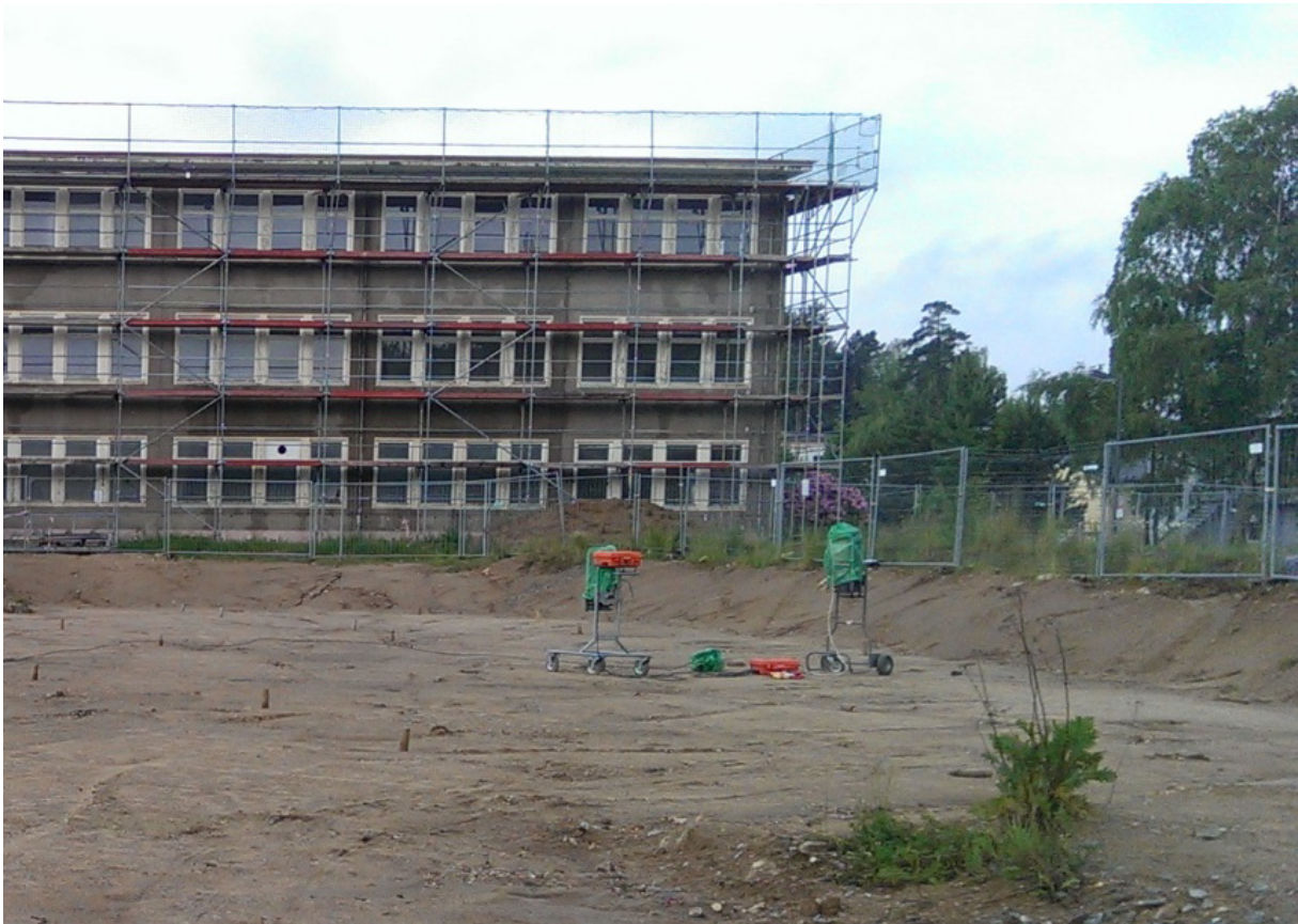
Abb. 4-15 Kollimierte ISG auf der verfüllten Baugrube im Abbruchbereich III
