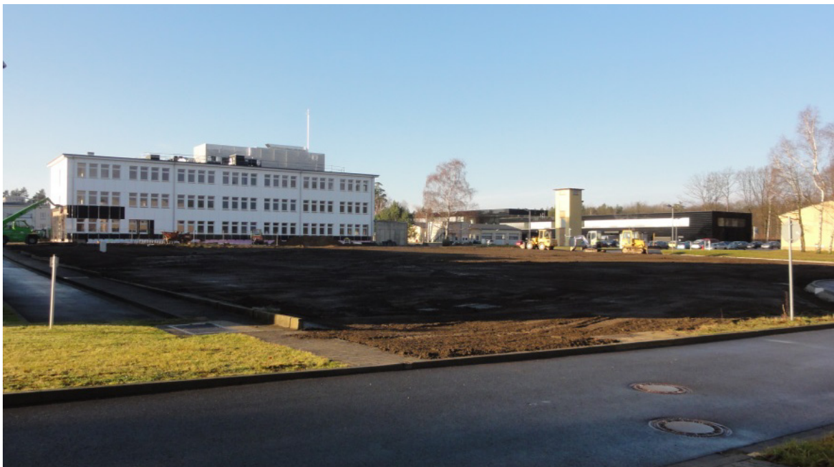
Abb. 4-4 Verfüllter Abbruchbereich III nach Abschluss der Rückbautätigkeiten
