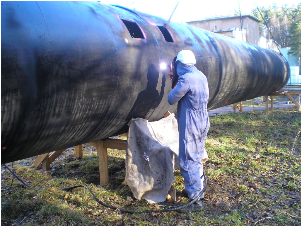
Abb. 4-1 Zerteilen des Fortluftschornsteins in einzelne Segmente
