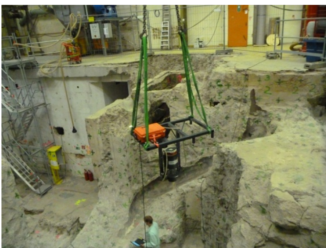
Abbildung 4.4.2-2: Messungen mittels In-situ- Gammaspektrometrie im Raum 30 (ehem. Reaktorkrypta)
