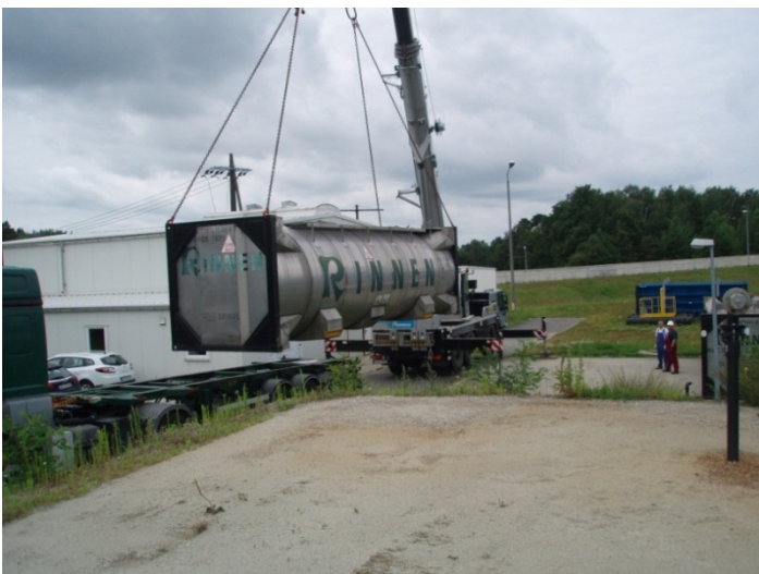
Abbildung 4.4.3-1: Errichtung der Logistikanlagen in Rainitz
