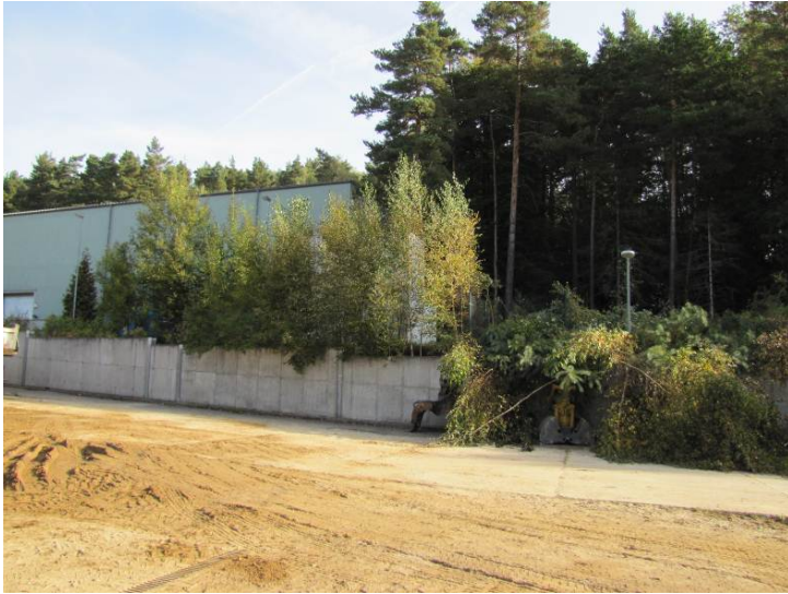
Abbildung 4.2.5.1-2: Entfernen des Bewuchses im Sanierungsgebiet
