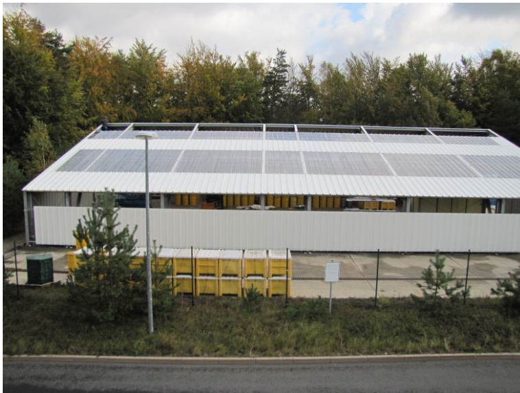
Abbildung 4.2.6.3-3: Stahlleichtbauhalle kurz vor der Fertigstellung der neuen Beplankung
