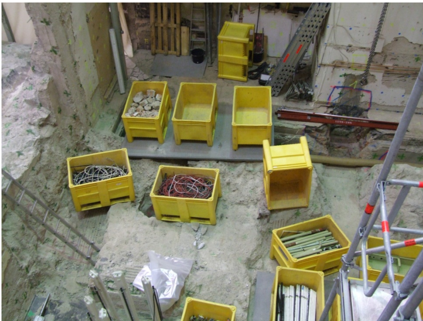
Die für das Jahr 2011 geplanten Maßnahmen zur Entkernung des Kellergeschosses konnten termingerecht bis zum Ende des Jahres fertig gestellt werden.
