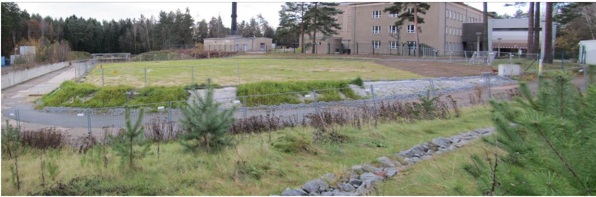
Abbildung 4.2.5.1-6: Freigegebenes Gelände des ehemaligen Lagers für radioaktive Abwässer
