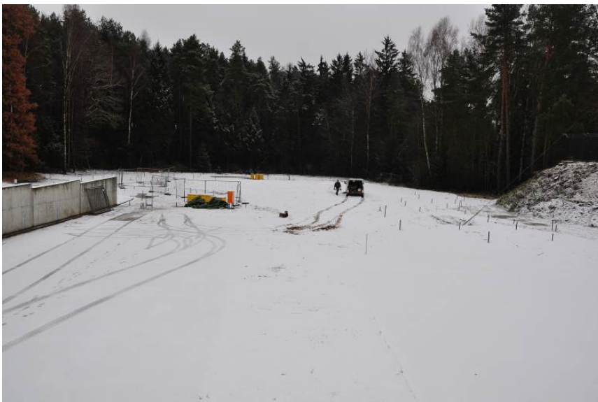
Abbildung 4.2.5.1-5: Sanierungsprojekt 2 nach Verfüllung der Baugrube der ehemaligen Abwasserbehälter
