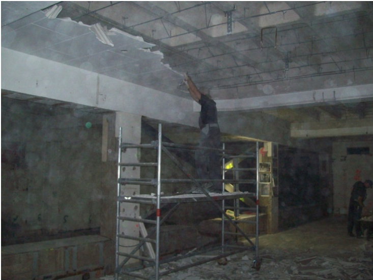
Abbildung 4.2.4-3: Abbruch der Gipsdecken im Ge- bäude 891
