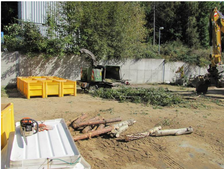
Abbildung 4.2.5.1-1: Verpacken des Grünguts in 500l PE-Boxen
