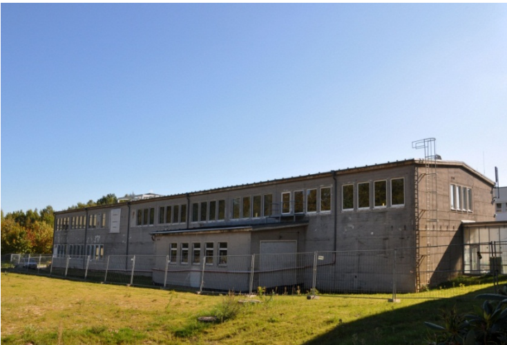
Abbildung 4.2.4-4: Das Gebäude 891 vor dem Be- ginn des Abrisses
