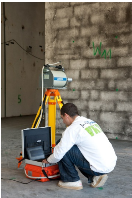
Abbildung 4.4.2-1: Messungen in der ehem. Abluftzentrale des Gebäudes 891
