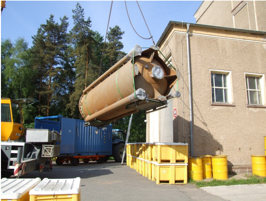
Abbildung 4.2.3-2: Abtransport Deareator
