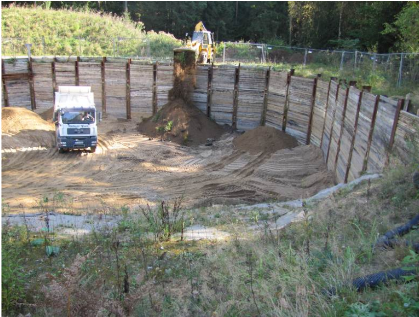
Abbildung 4.2.5.1-4: Baugrube der ehemaligen Abwasserbehälter während der Verfüllung
