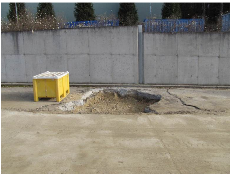
Abbildung 4.2.5.1-3: Dekontaminierter Straßenbereich im Sanierungsgebiet
