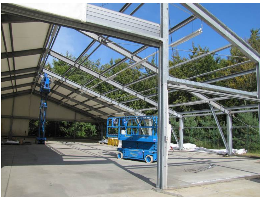
Abbildung 4.2.6.3-2: Abbau der Gewebeplane der Stahlleichtbauhalle
