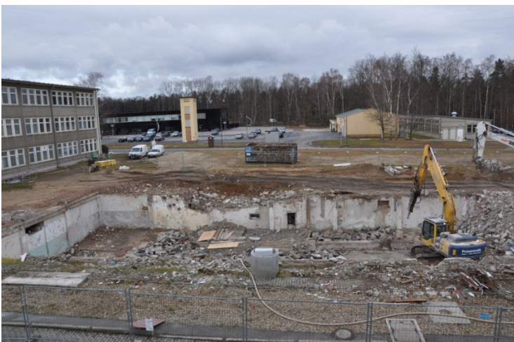
Abbildung 4.2.4-5: Blick in den Kellerbereich nach Abriss der aufgehenden Struktu- ren des Gebäudes 891
