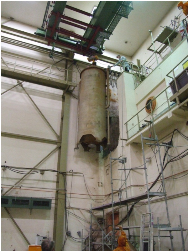
Abbildung 4.2.3-1: Ausbau Deaerator
