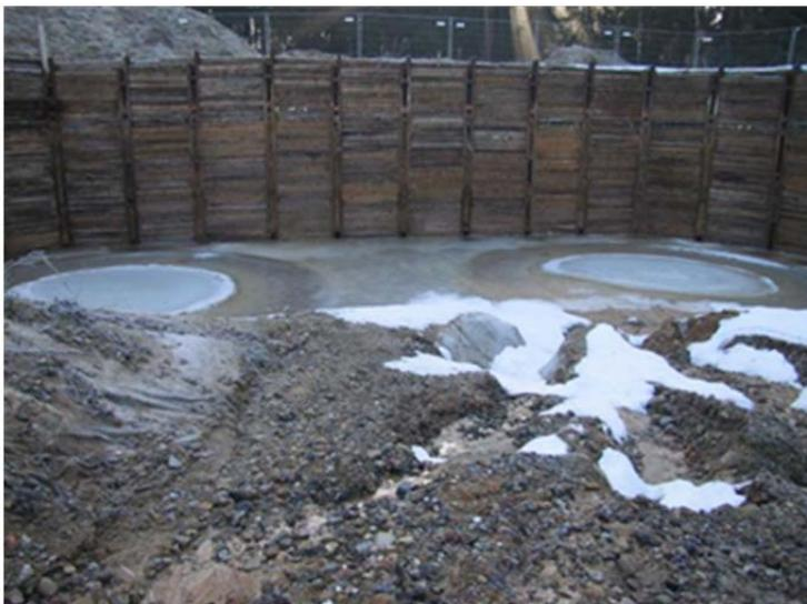
Abb. 4-10: Baugrube nach Rückbau der Abwasserbehälter
