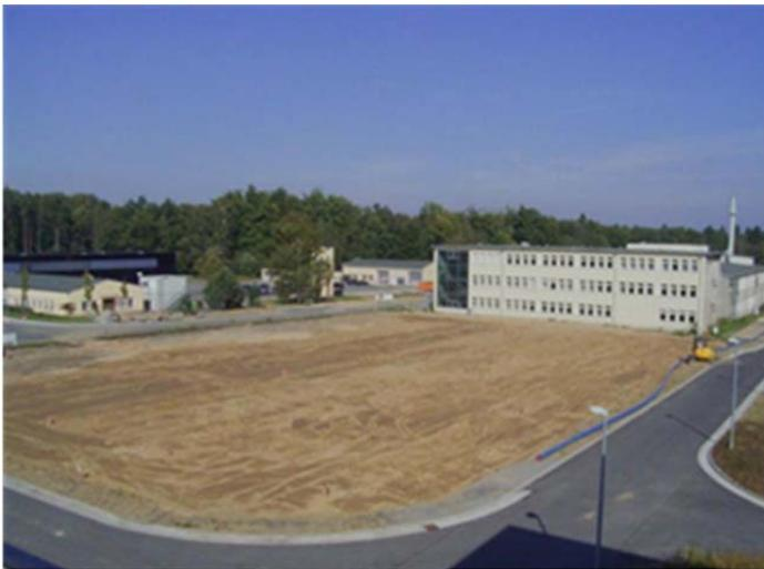
Abb. 4-7: Abbruchbereich I nach Aufbringen der Abdeckschicht
