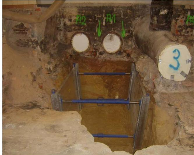
Abb. 4-5: Verbau zum Abbau der Abluftleitungen
