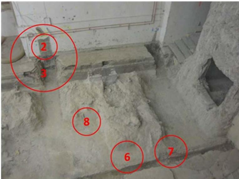
Abb. 4-6: Mess- und Probenahmepositionen im Fundament Heiße Kammer
