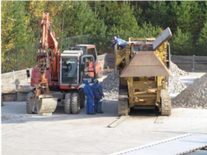
Abb. 5-7: Brechen von Betonabschirmsteinen im Pufferlager
