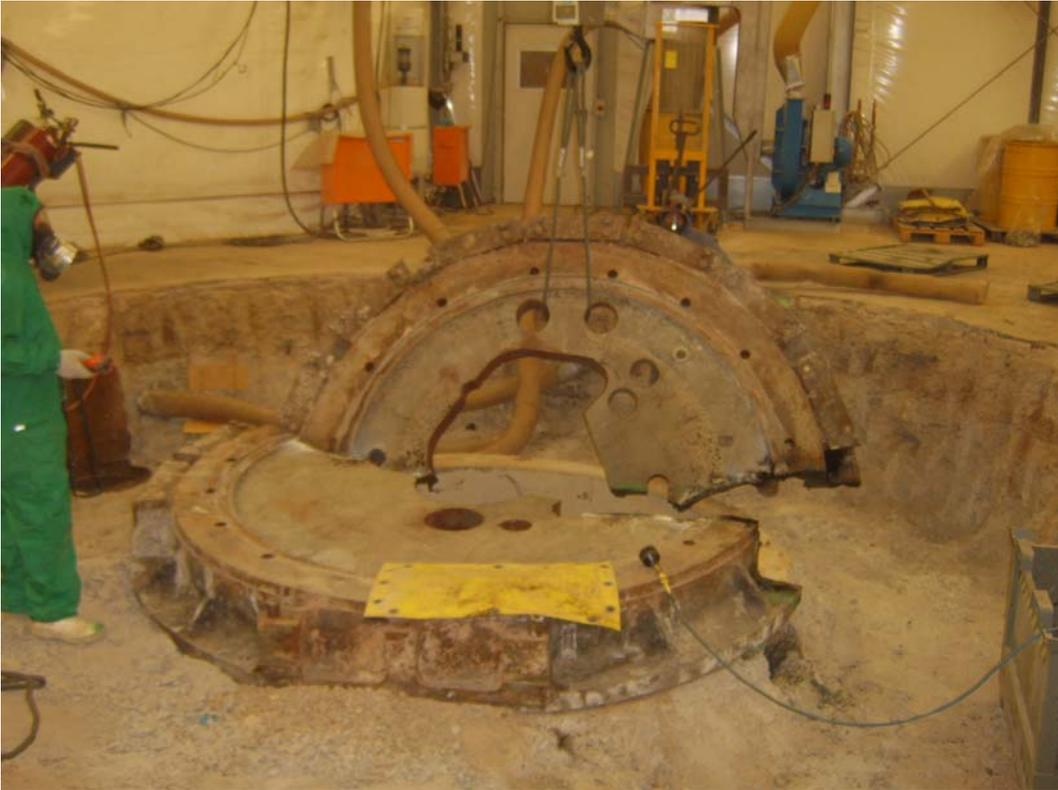
Abb. 3.2.3-3: Demontage der Reaktorgrundplatte
