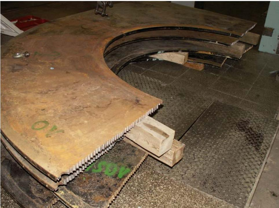
Abb. 3.2.6.1.4-2: Zerlegte Teile der aktivierten Spulhalterungen
