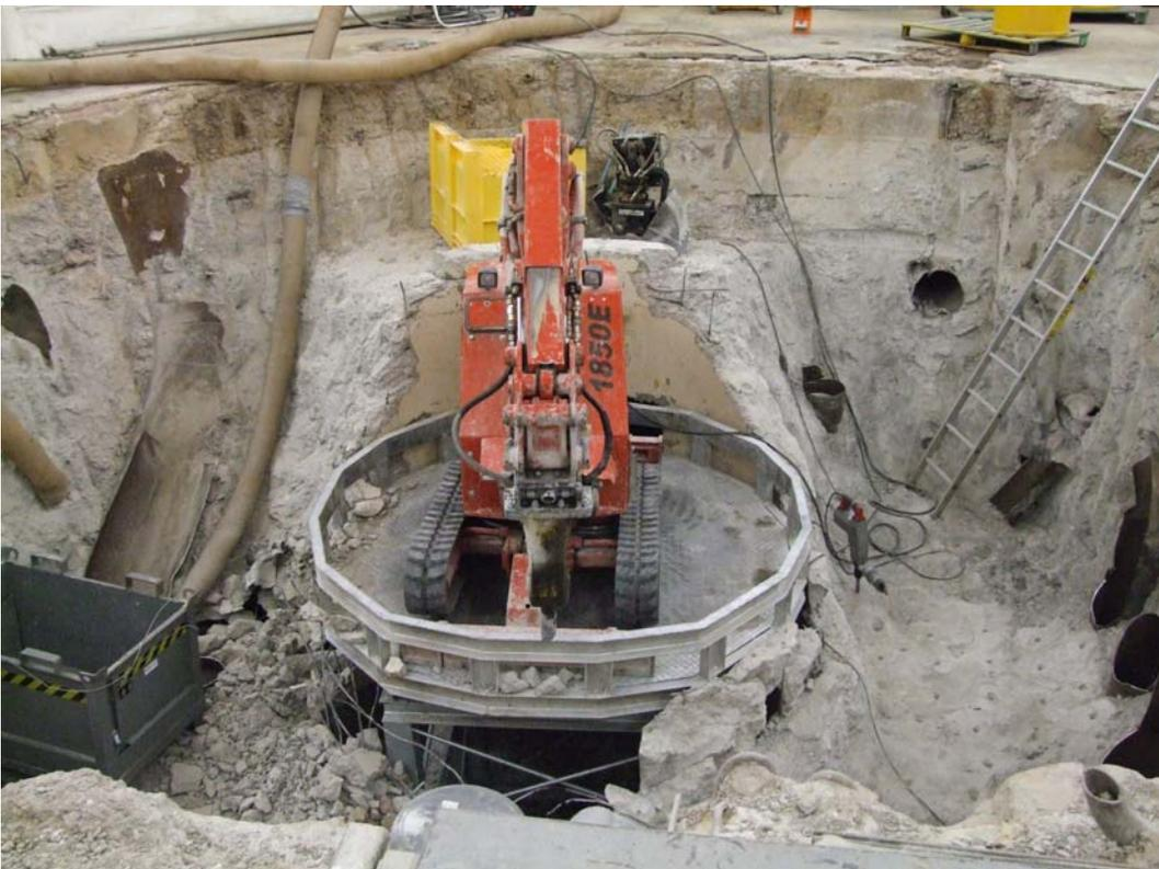
Abb. 3.2.3-4: Abbau der in Beton verlegten Abluftkanäle
