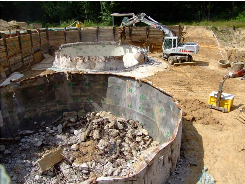
Abb. 3.2.5.2-1: Abriss der ehemaligen Behälter für radioaktives Abwasser mit der Hydraulikscherre
