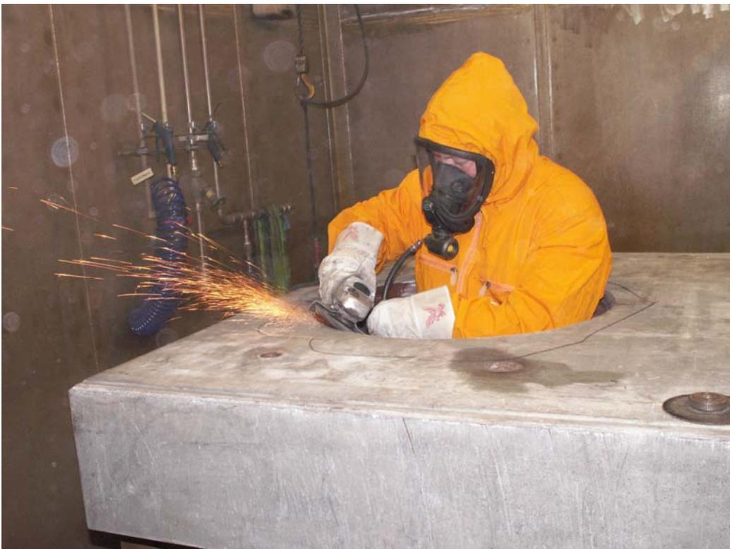
Abb. 3.2.6.1.2-1: Dekontaminieren eines Abschirmriegels des RFR mittels Schleifen
