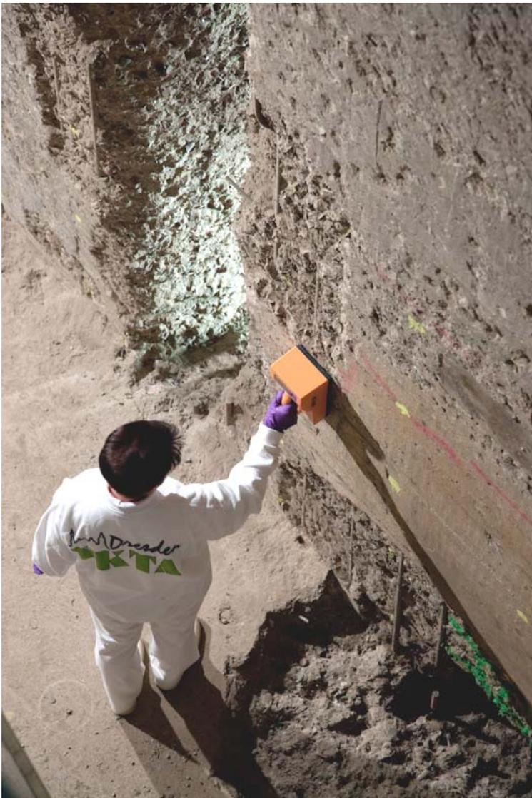
Abb. 3.4.2-1: Voruntersuchungen an der dekontaminierten Gebäudestruktur des Wassertressors des Gebäudes 91
