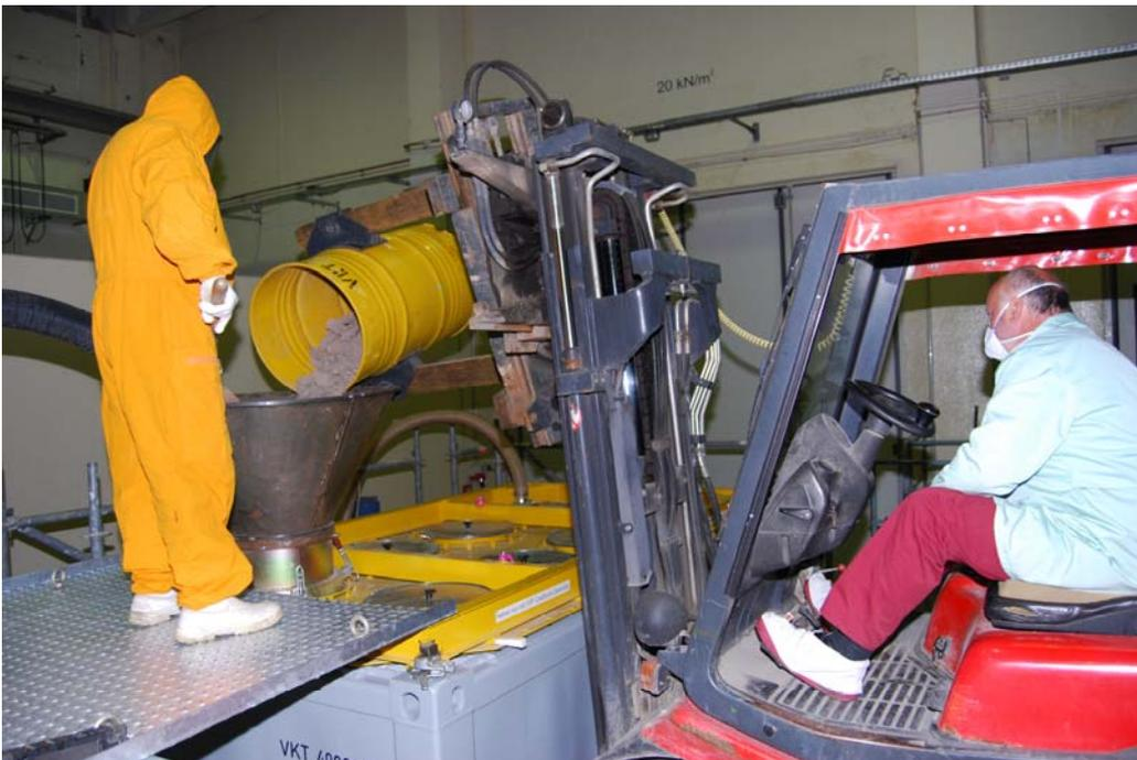
Abb. 3.2.6.1.3-2: Ausschütten eines Bauschuttfasses in einen KC IV mittels Gabelstapler und Spezialdeckel
