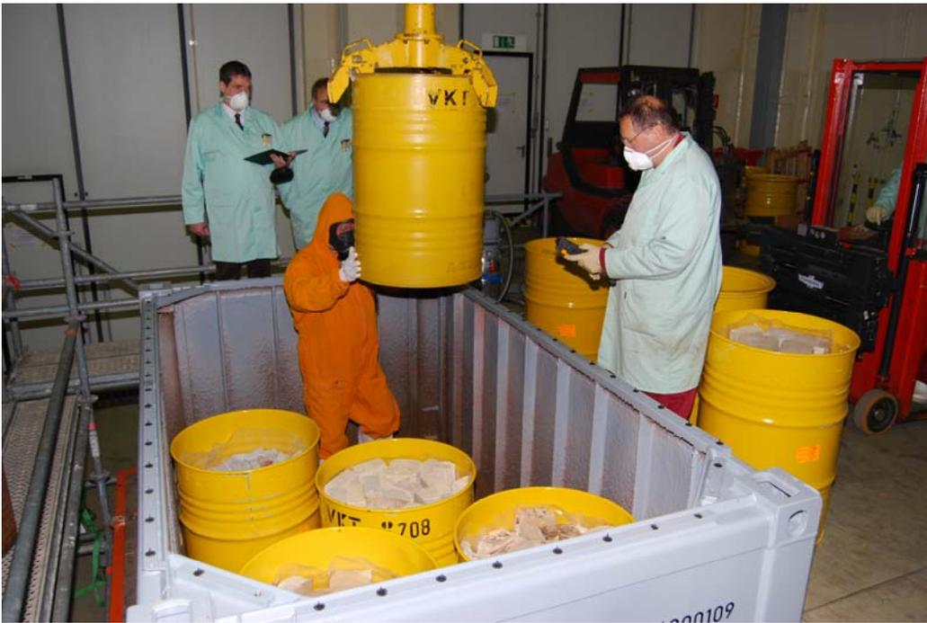
Abb. 3.2.6.1.3-1: Einstellen von Fässern mit Bauschutt in einen KC IV
