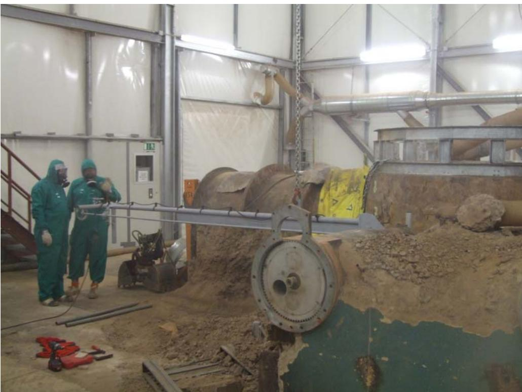
Abb. 3.2.3-2: Fernhantierte Demontage der Strahlrohre und Strahlrohrverschlüsse
