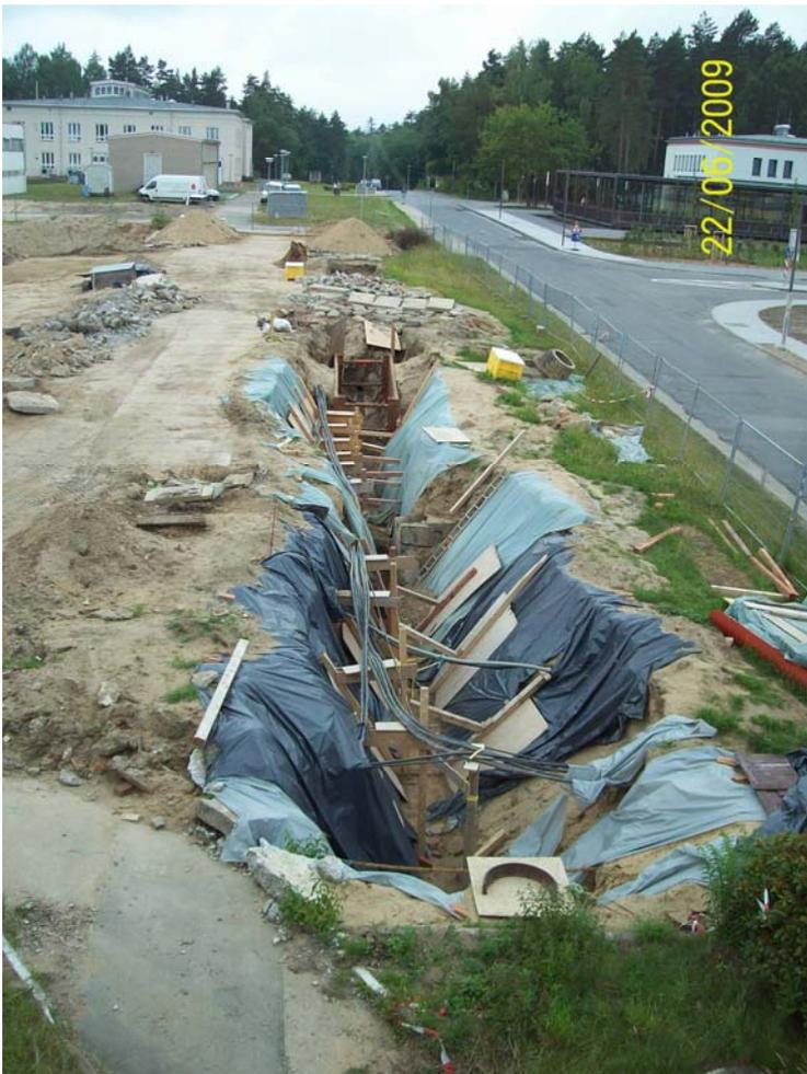
Abb. 3.2.4-2: Gräben der entnommenen Schmutzwasserleitung im Abbruchbereich I
