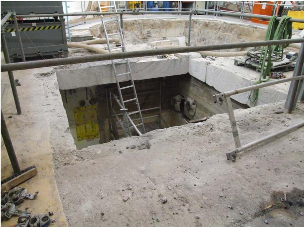
Abb. 3.2.3-1: Seilsägearbeiten in der Reaktorhalle zum Freilegen der Heißen Kammern
