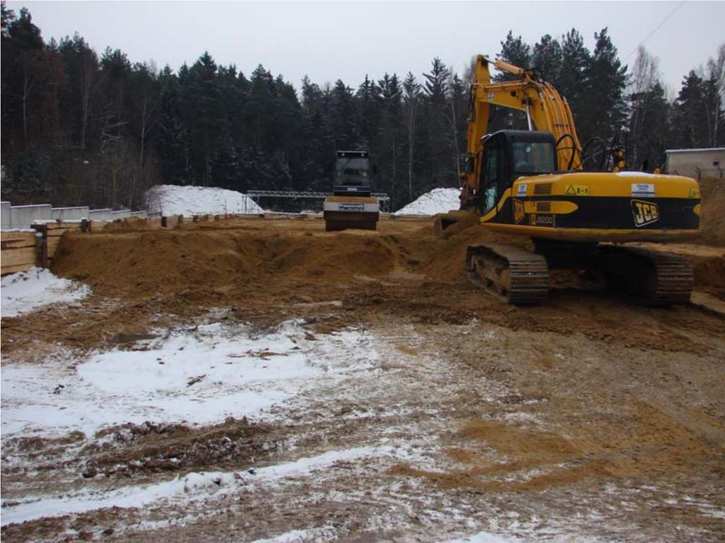
Abb. 3.2.5.1-2: Verfüllung des Verbaus am Gebäude 99
