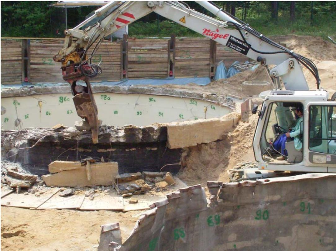
Abb. 3.4.2-4: Ausbau des ehemaligen Abwasserbehälters (Gebäude 30.3)
