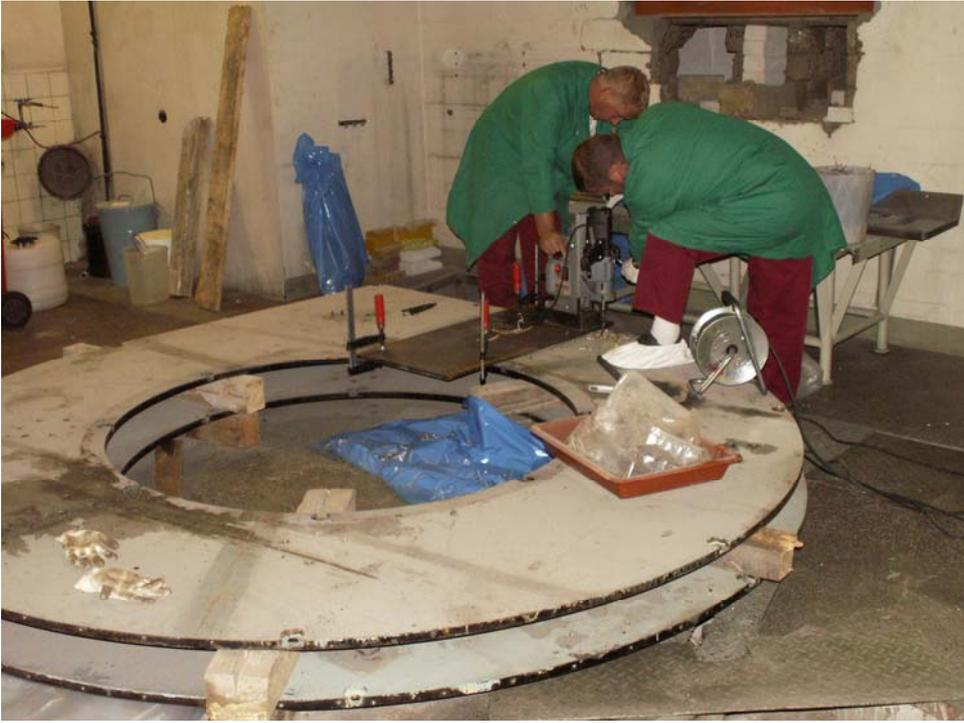
Abb. 3.2.6.1.4-1: Zerlegung von aktivierten Spulhalterungen des Zyklotrons
