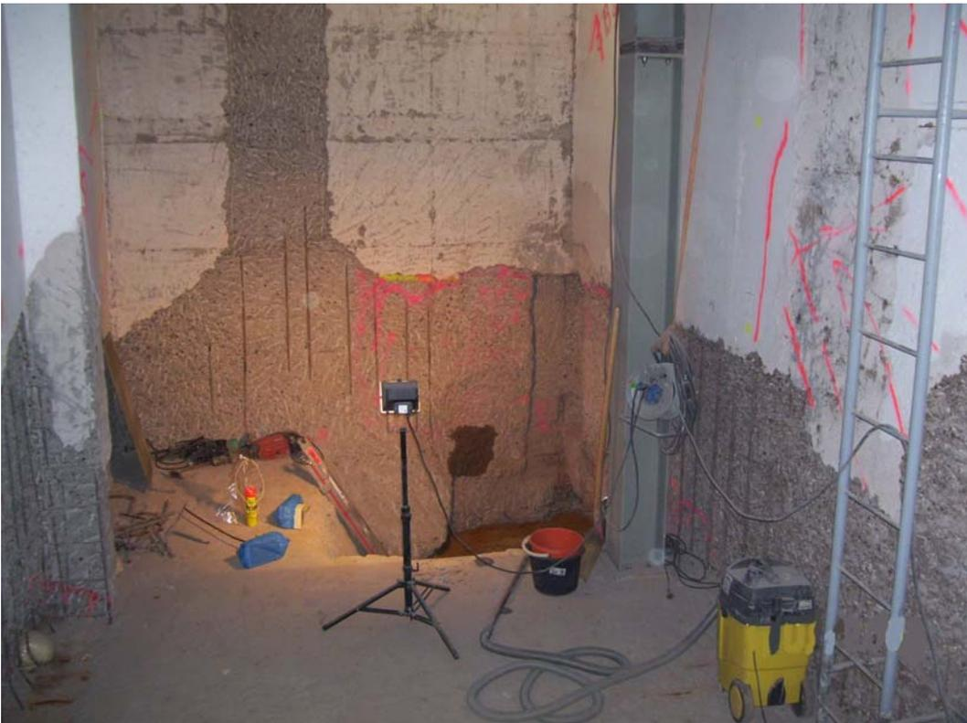
Abb. 3.2.4-5: Dekontaminationsarbeiten im Tiefkeller Gebäude 91
