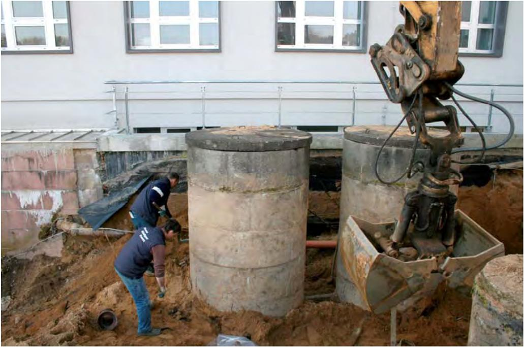
Abb. 3.2.5.3-2: Freilegen Hebeanlagen im Arbeitsfeld 2
