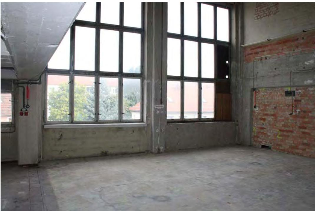
Abbildung 3.4.3-3: Teilansicht Neutronengenerator-Raum nach Beräumung und Wanddekontamination (rechte Bildseite)
