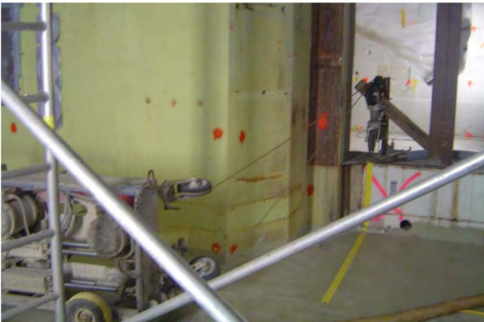
Abb. 3.2.4-6: Trockenseilsägen zum Freischneiden des Heiße-Zellen-Trakts aus der Gebäudestruktur
