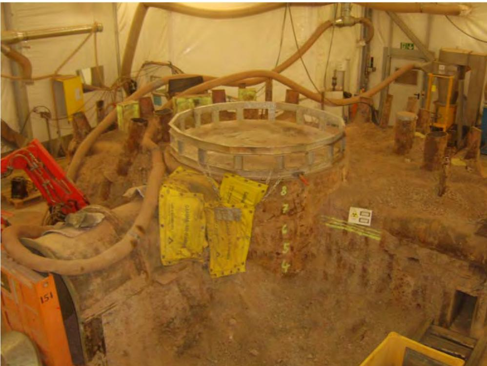
Abb. 3.2.3-3: Stahlblöcke im Betonkörper des RFR
