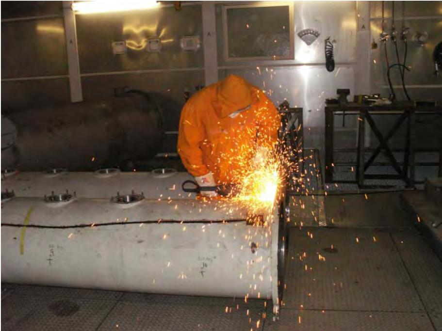
Abb. 3.2.6.1.4-1: Zerlegen von aktivierten Teilen des Zyklotrons
