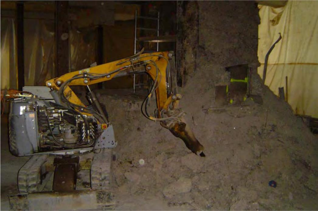
Abb. 3.2.4-7: Elektrokleinbagger mit Abbruchmeißel beim Abbrechen der Schwerbetonstruktur des Heiße-Zellen-Traktes im Gebäude 91
