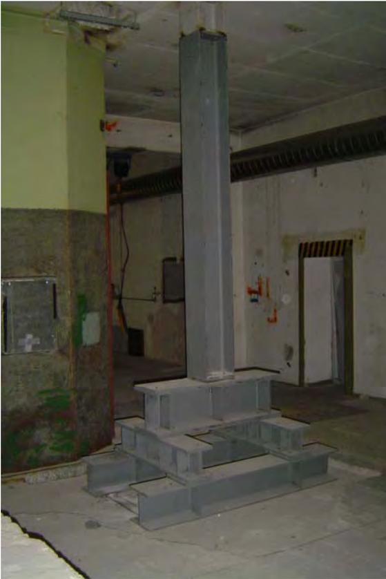
Abb. 3.2.4-5: Stützkonstruktionen als statische Ersatzmaßnahme vor dem Abbruch des Heiße-Zellen-Traktes im Gebäude 91
