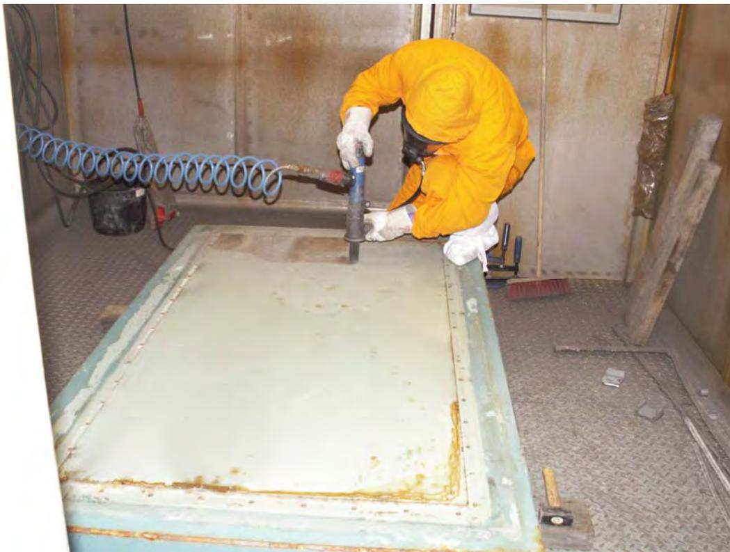
Abb. 3.2.6.1.2-1: Dekontaminieren einer HZ-Tür mittels Nadler
