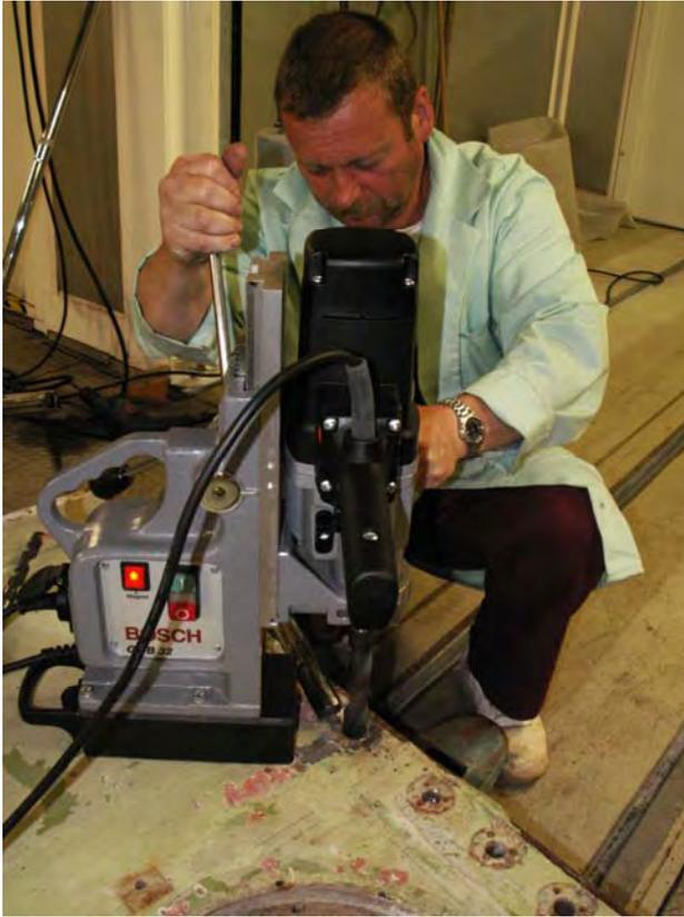
Abb. 3.2.6.1.2-2: Ausbohren von Kontaminationen aus Abschirmsegmenten
