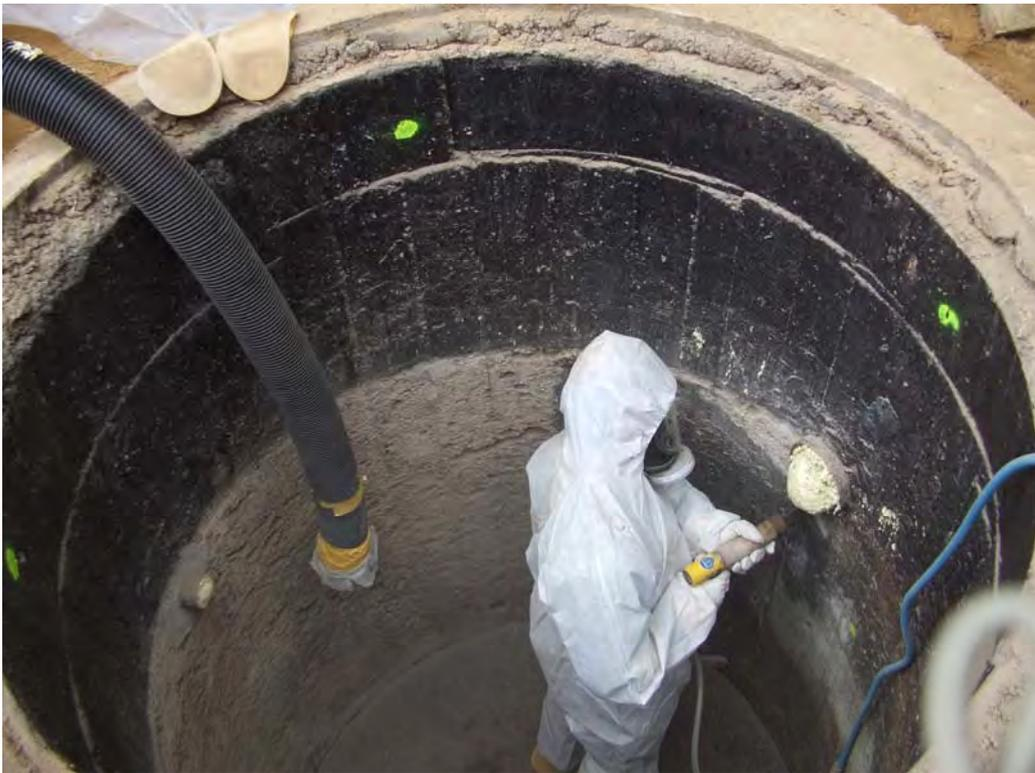
Abb. 3.2.5.3-3: Dekontamination Hebeanlagen im Arbeitsfeld 2
