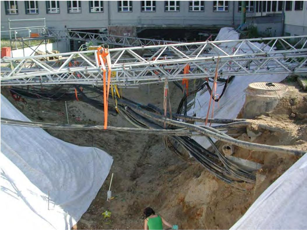
Abb. 3.2.5.3-5: Kabelsicherung im Arbeitsfeld 2
