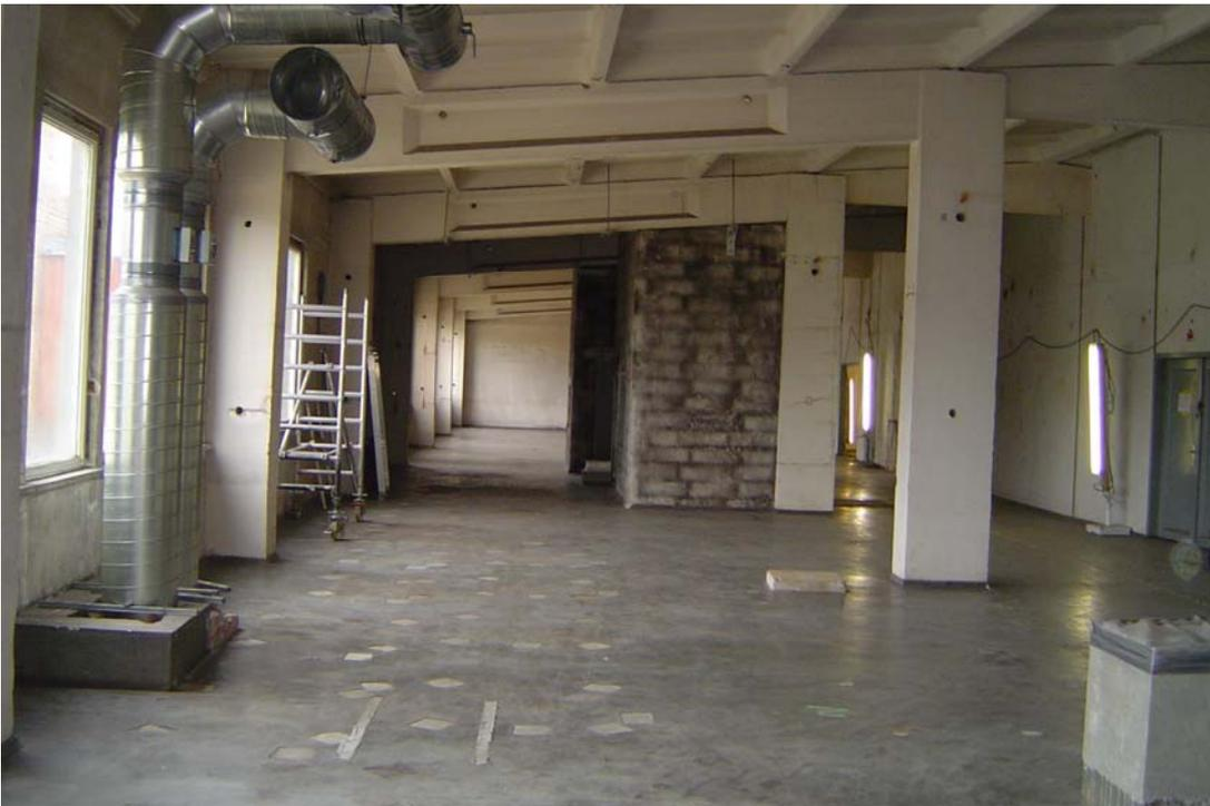
Abb. 3.2.4-3: Ausgeräumter Abluftanlagenraum im Obergeschoss des Gebäudes 91 (vorn links - neu installierte LTA-Ersatzanlage für Abbruch des Heiße-Zellen-Trakts)
