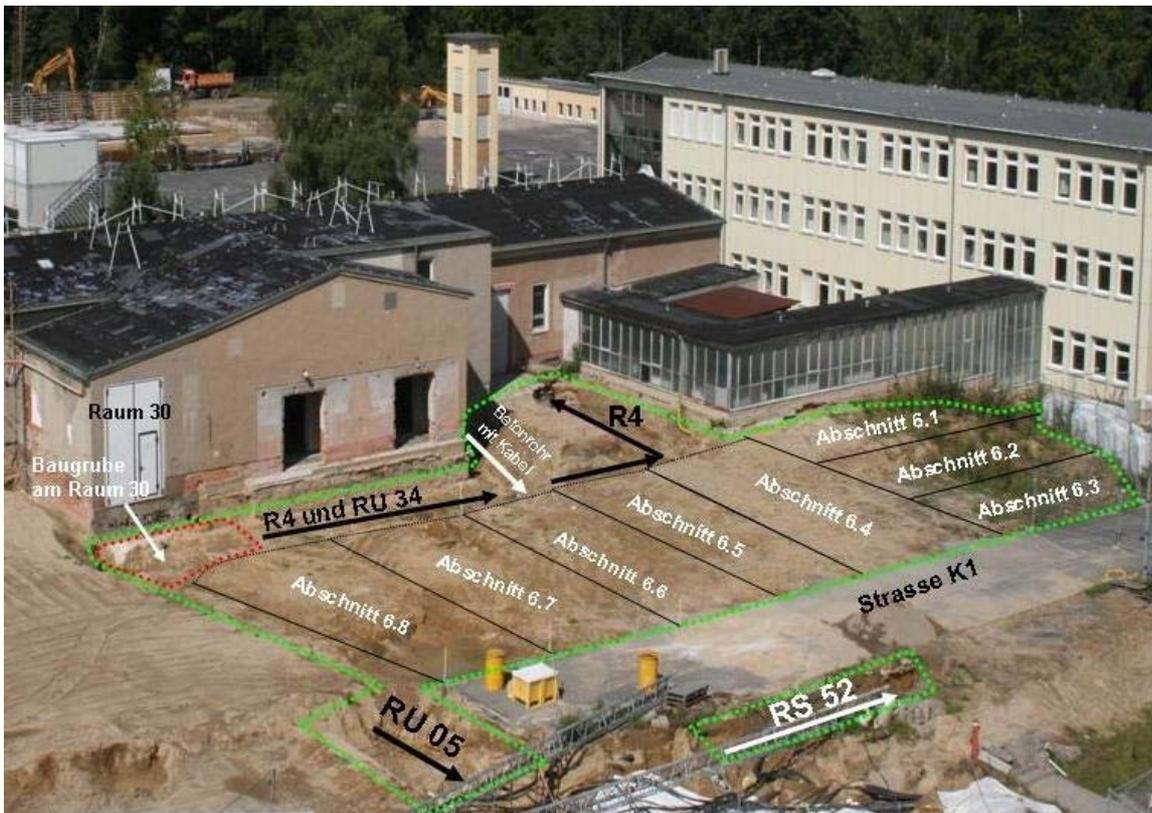
Abb. 3.4.2-2: Betriebshof zum Gebäude 8d Entnahmebereiche der Bodenproben im Rahmen der Entscheidungsmessungen für die Freigabe (Rückbaukomplex 2)
