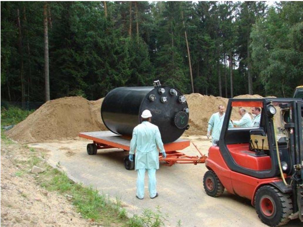
Abb. 3.2.5.2-4: Behälter der Sammelanlage beim Abtransport in die ESR
