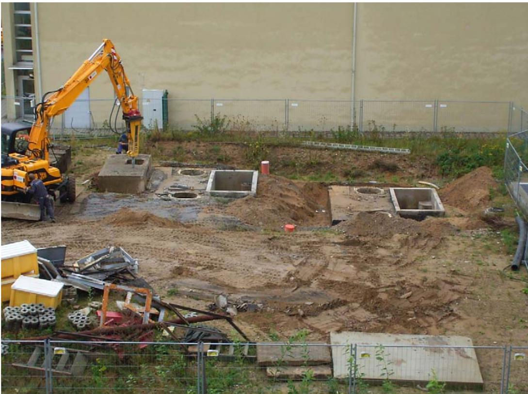
Abb. 3.2.5.3-3: Abbruch der Behälterdecken der Gebäude 99.2 – 99.4
