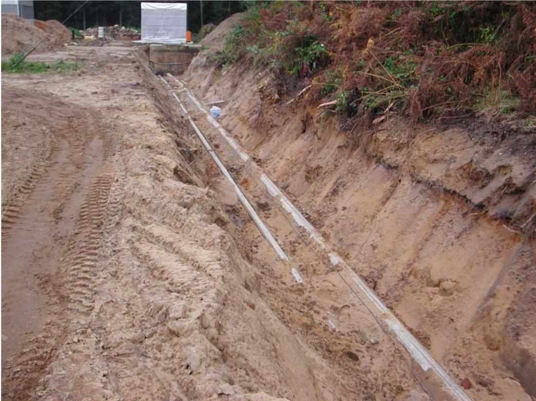
Abb. 3.2.5.2-5: Ausbau von Rohrleitung der Speziellen Kanalisation Teil 4
