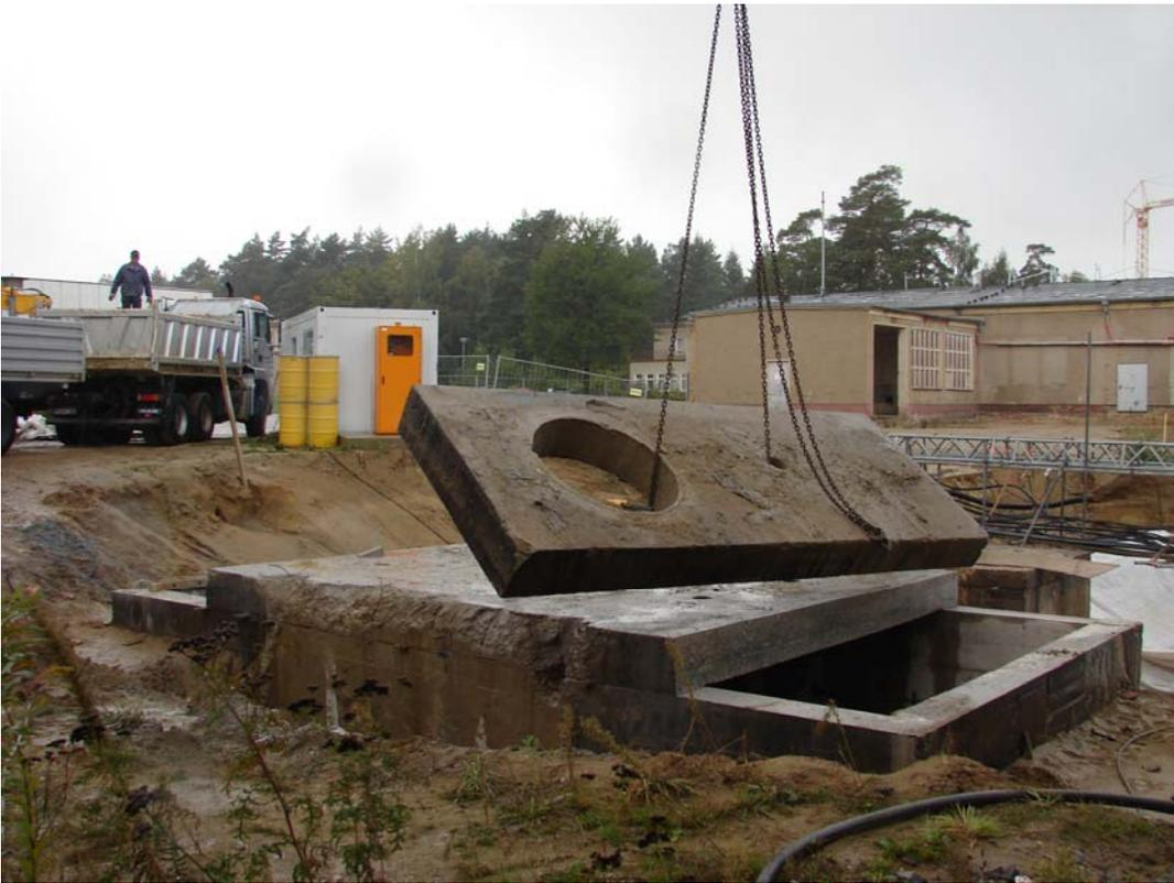
Abb. 3.2.5.3-4: Abnehmen der gesägten Deckenplatten vom Behälter Gebäude 99.2
