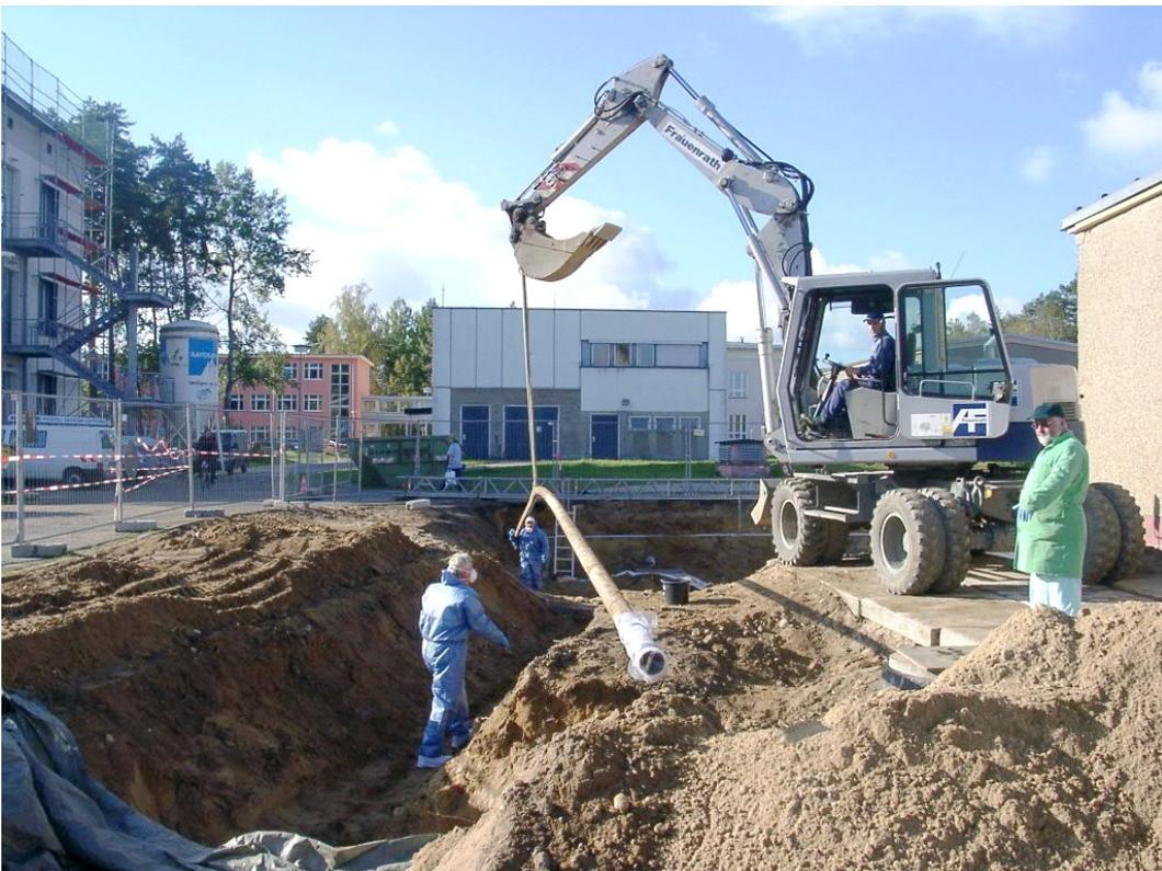
Abb. 3.2.3.4-2: Herausnahme einer freigelegten Rohrleitung im Sanierungsabschnitt 1 des Hofes Gebäude 8d
