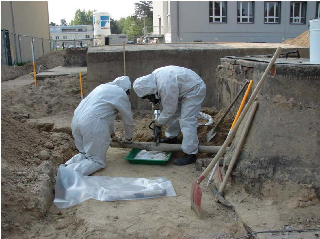
Abb. 3.2.4.2-1: Gebäude 99.1-4: Freigelegte Behälteroberflächen und Rückbau von Rohrleitungen
