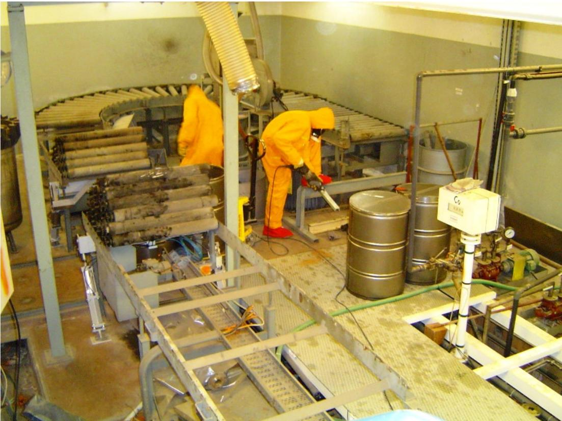
Abb. 3.2.3.2-3: Demontage der verfahrenstechnischen Einrichtungen im Raum 022 des Gebäudes 91
