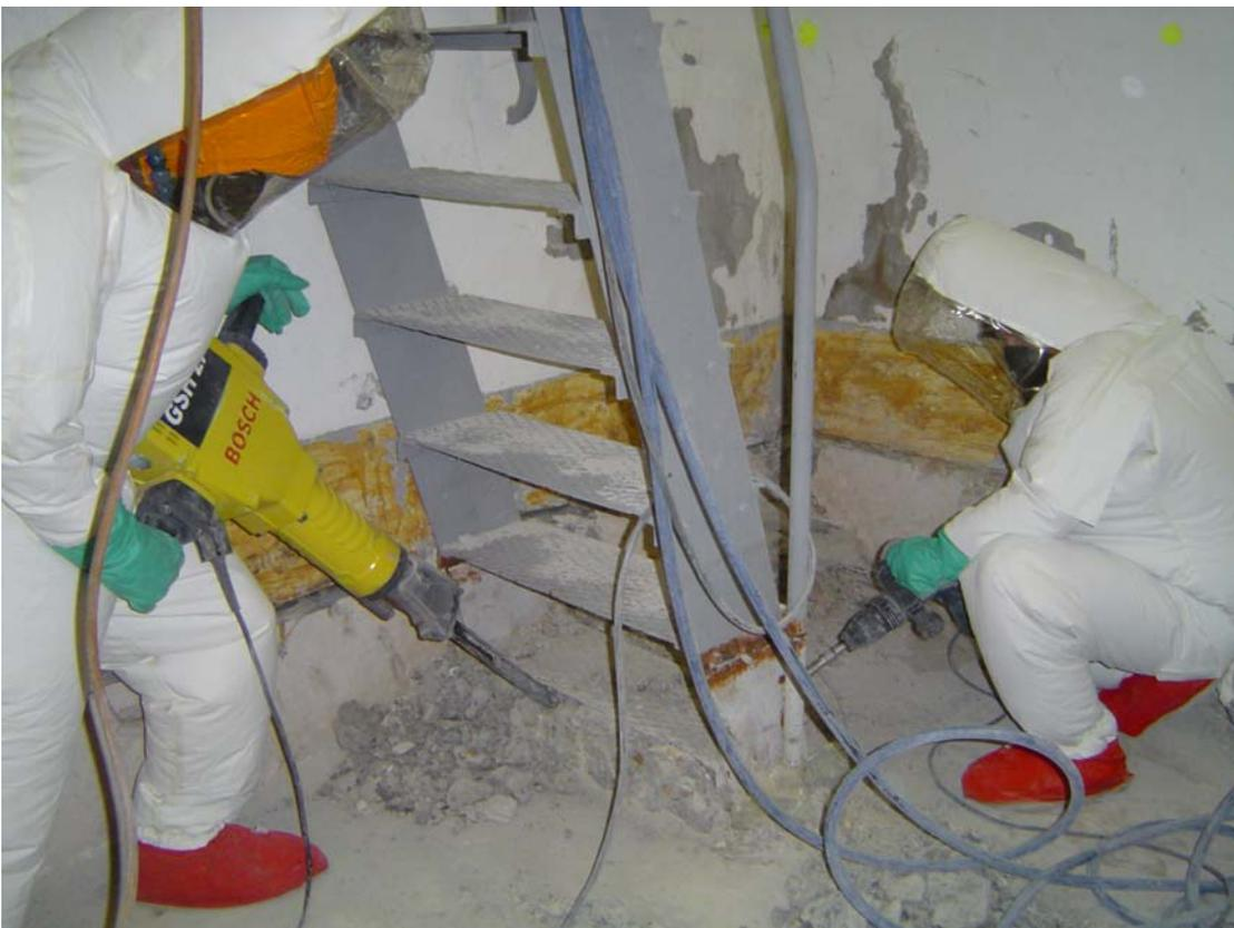
Abb. 3.2.3.2-1: Rückbaupersonal in fremdbelüfteten Schutzanzügen beim Abtragen von kontaminierten Betonstrukturen im Tiefkeller des Gebäudes 91
