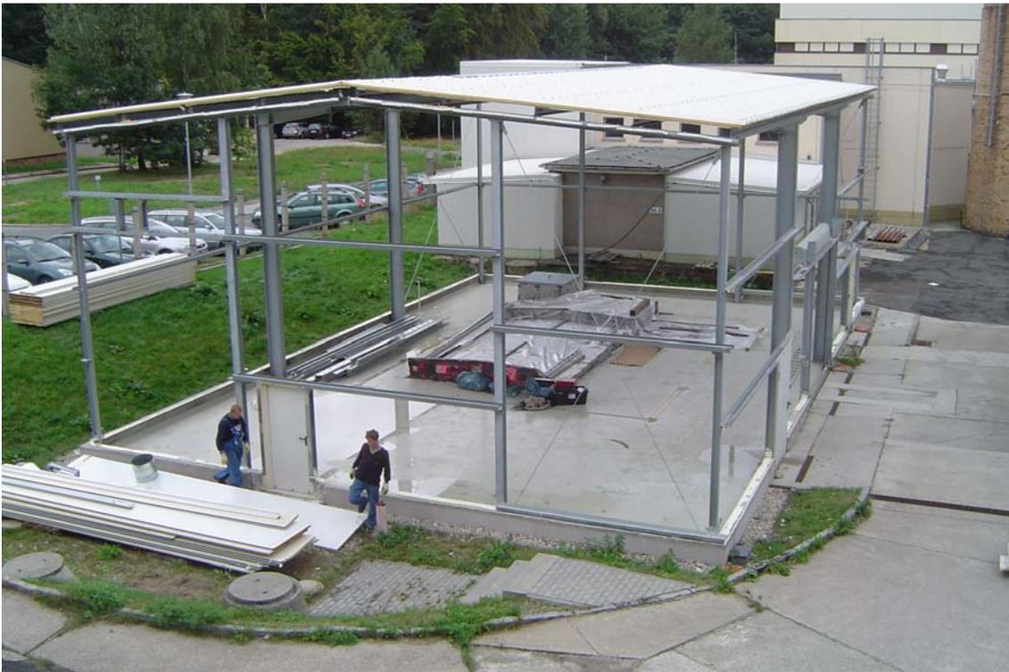
Abb. 3.2.3.4-3: Stahleichhalle über dem AMOR-Abklinglager (Gebäude 91.4) nach der Demontage der seitlichen Sandwichpaneele
