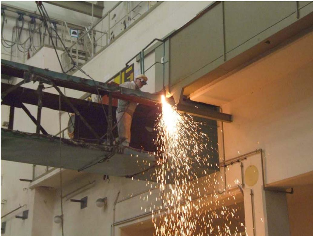
Abb. 3.2.2.1-1: Abtrennen der Reaktorbrücke
