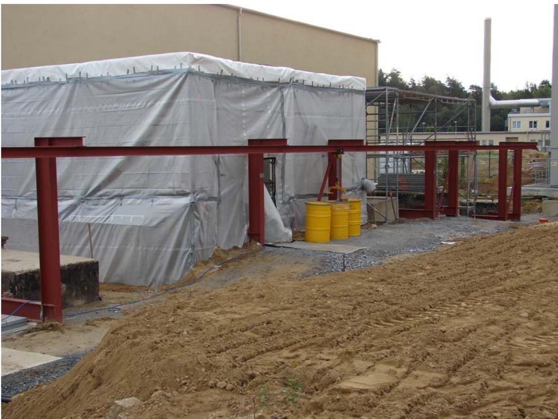
Abb. 3.2.4.2-2: Arbeitszelt mit lufttechnischer Filteranlage über den Behältern des Gebäudes 91.2
