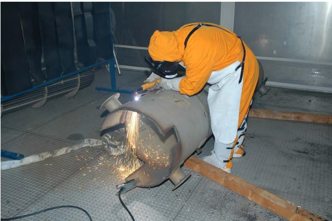
Abb.: 3.2.5.1.2-2 Zerlegen des Wärmeübertragers 5 des RFR mittels Plasmaschneiden
