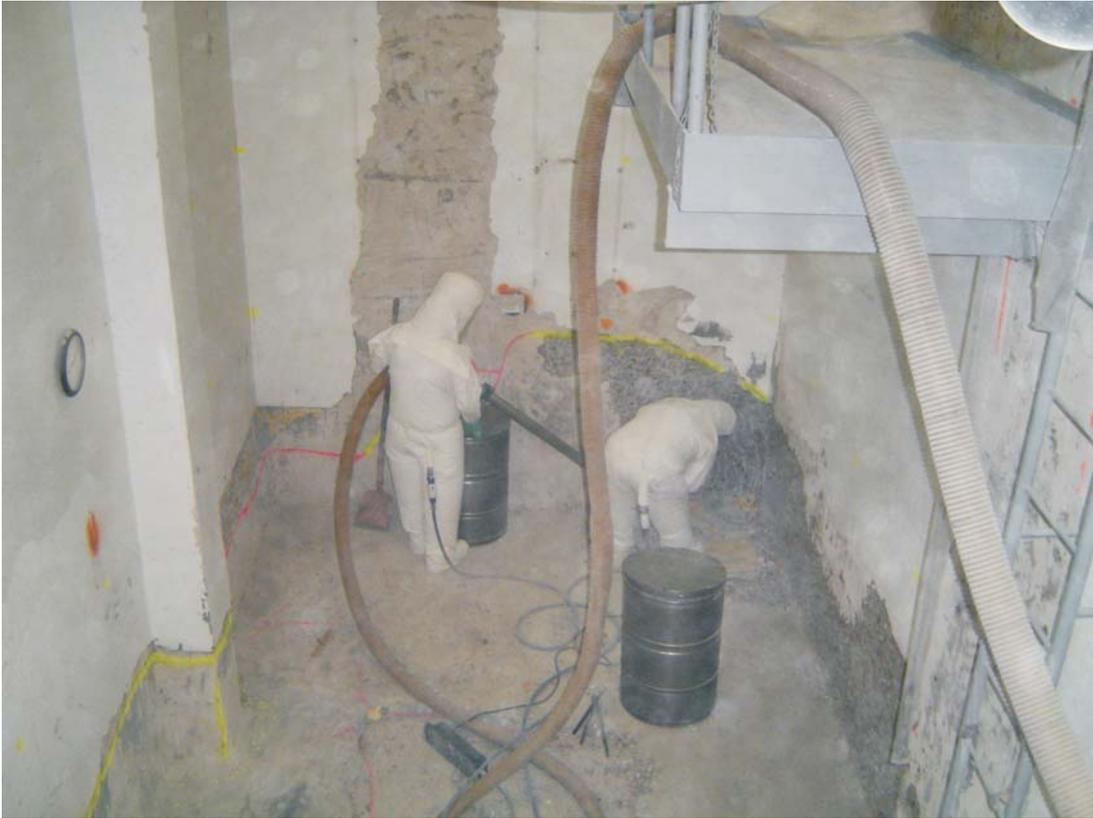
Abbildung 3.2.3.2-2: Abtragen der Betonoberflächen im Tiefkeller
