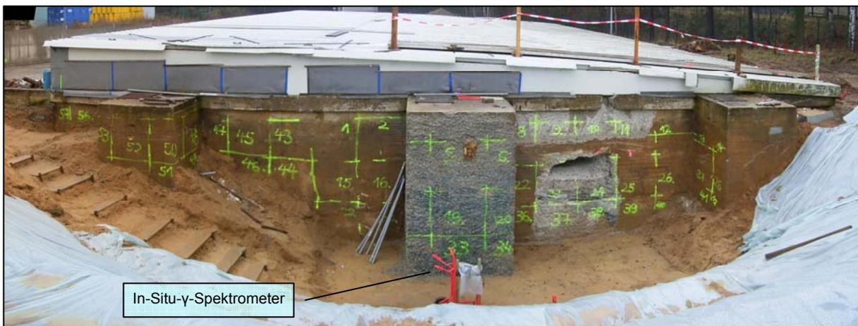
Abbildung 3.3.5-1: Baugrube an der NW-Seite des Gebäudes 99 mit wetterfest verpacktem In-situ- $\gamma$ -Spektrometer
