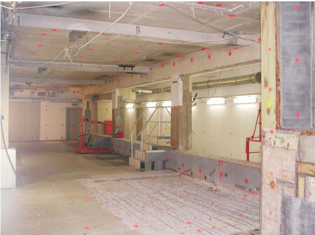
Abbildung 3.2.3.1-3: Servicekorridor der AMOR I nach Abschluss des Anlagenabbaus
