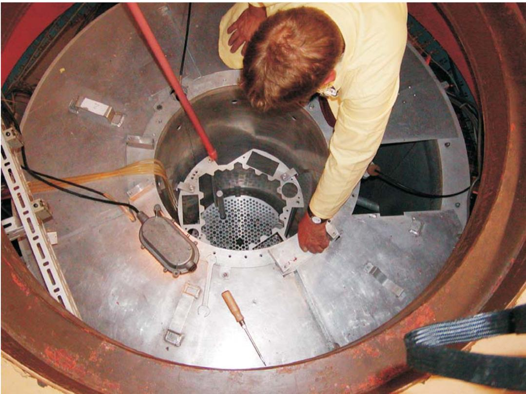
Abbildung 3.2.5.5-1: Demontage der Einbauten des Reaktorbehälters des ZLFR
