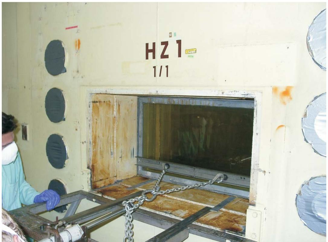
Abbildung 3.2.3.2-1: Ausbau der Bleiglasfenster der Heißen Zelle 1
