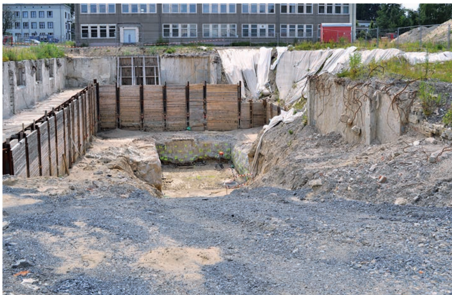
Baugrube mit Sicherungsverbau nach erfolgtem Totalabbruch von Wassertresor und Tiefkeller – im Hintergrund das zur Weiterverwendung als Strahlenschutzzentrale freigegebene Gebäude
