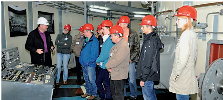
Besichtigung des Blocks 6 des ehemaligen Kernkraftwerks
