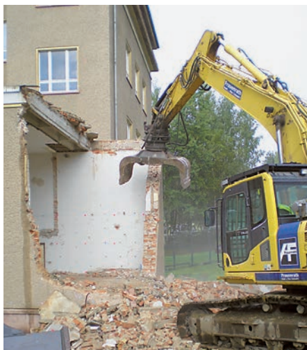
Der Abbruchbagger der Abrissfirma im Einsatz.
