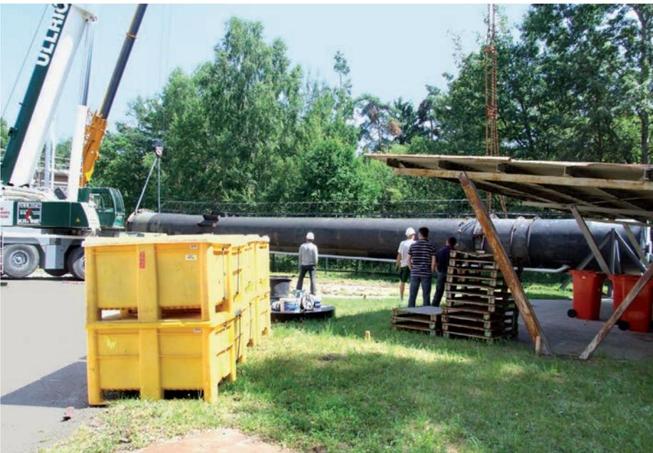
Am 16. Juli 2013 um ca. 14:00 Uhr erhob sich eine „schwebende Zigarre“ über dem Gelände des ehemaligen Rossendorfer Forschungsreaktors (RFR). Der alte Fortluftschornstein, 1957 von der Firma Hellwig aus Dresden errichtet, im aufgebauten Zustand ca. 40 Meter hoch und ca. 20 Tonnen schwer, wurde nun demontiert.
