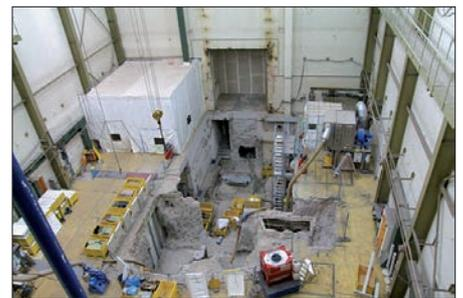
Reaktorhalle: Reaktorbaukörper und Heiße Kammern komplett rückgebaut
