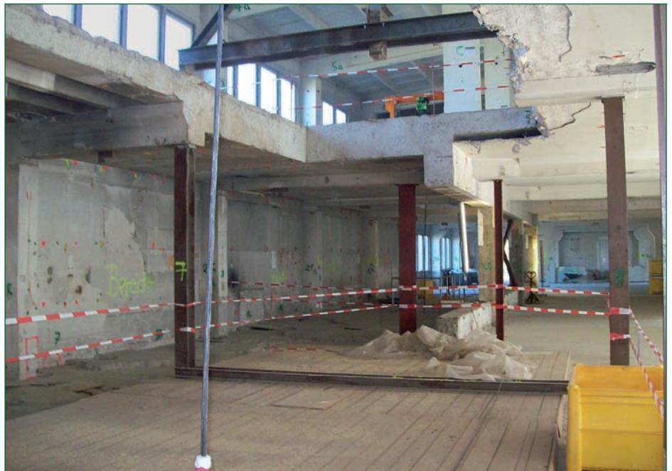
„Entkerntes“ Erdgeschoss des Gebäudes 91 vor dem Abriss
