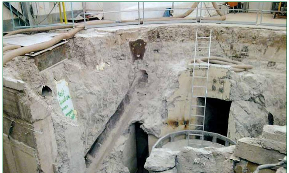
Abbruch der Betonstrukturen unter dem Reaktor
