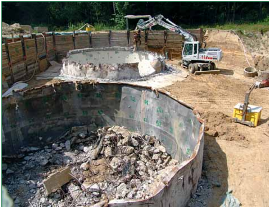
Abriss der ehemaligen Reaktorabwasserbehälter
