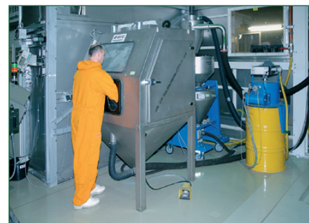
Dekontaminieren mithilfe der Trockenstrahlanlage
