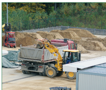
Beim Rückbau anfallendes Erdreich wird homogenisiert und untersucht
