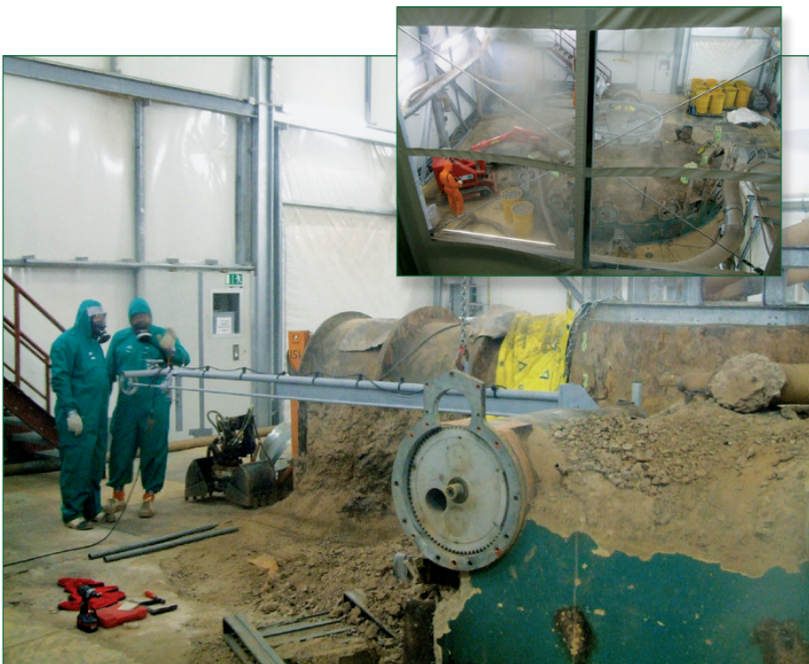
Kleines Bild oben: Ein Blick durch die Einhausung macht klar: Viel steht nicht mehr vom alten Reaktor Großes Bild: Eingebettet in den Betonmantel des Forschungsreaktors konnten durch Strahlrohre Neutronen in die Reaktorhalle gelangen, um dort für Experimente verwendet zu werden
