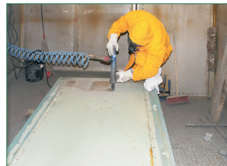
Dekontaminieren einer Stahlplatte mit einem Nadler
