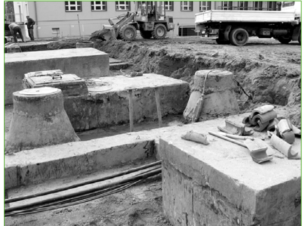
Rückbaukomplex 3 – Spezielle Kanalisation, Beginn Rückbau
