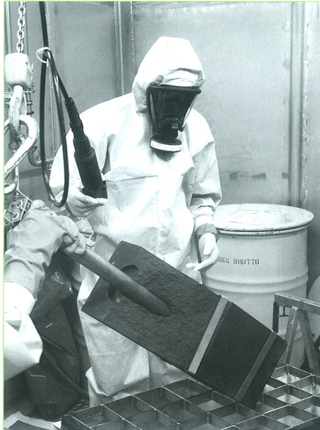
Zerlegearbeiten im Caisson
