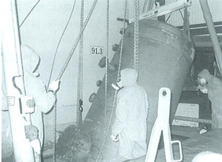
Im Januar 2004 hat der Rückbau in diesem Gebäudekomplex begonnen. Ziel dieses Vorhabens ist der Rückbau aller Anlagenteile und Einrichtungen, die der Handhabung und Lagerung der mittel- und schwachradioaktiven flüssigen Abfälle aus der Isotopenproduktion dienen. Die Demontage und Entfernung der Prozessanlagen, Versorgungseinrichtungen, Hilfs- und Nebenanlagen sowie der sicherheitstechnischen Einrichtungen wird schrittweise vorgenommen.
