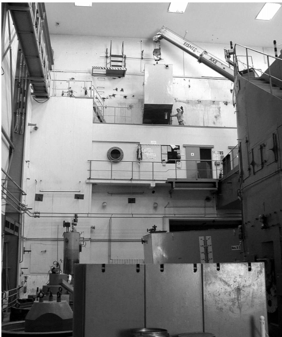
Demontage eines Reservewasserbehälters mittels Autokran in der RFR-Halle
