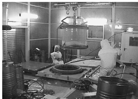
Anheben eines Behältersegments mit Innenzangengreifer des AMOR-Abklinglagers
