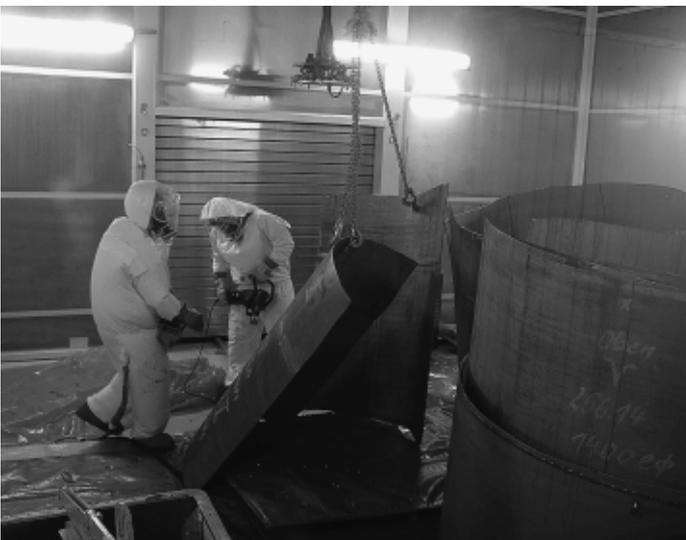
Ziehen des äußeren eckigen Sicherheitsbehälters
