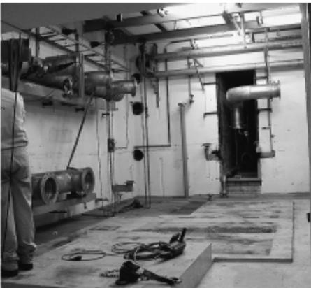
Vom 30. Januar 2001 bis 19. Juli 2002 stand der Rückbau des 1. Kühlkreislaufs im Rahmen des 3. Schrittes der Stilllegungsmaßnahmen des RFR an. Der Rückbau des RFR wurde bisher vom Betriebspersonal durchgeführt. Die zu handhabenden Massen und Abmessungen der eingebauten Komponenten machten den Einsatz einer externen Fachfirma erforderlich. Den Auftrag dazu erhielt BABCOCK NOELL NUCLEAR GmbH.
