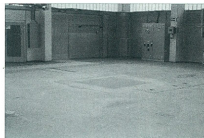
Nullleistungsreaktoren RAKE und RRR: Beide Reaktoren wurden abgebaut und das ehemalige Reaktorgebäude dem FZR im Jahr 2000 zur konventionellen Nutzung übergeben.
