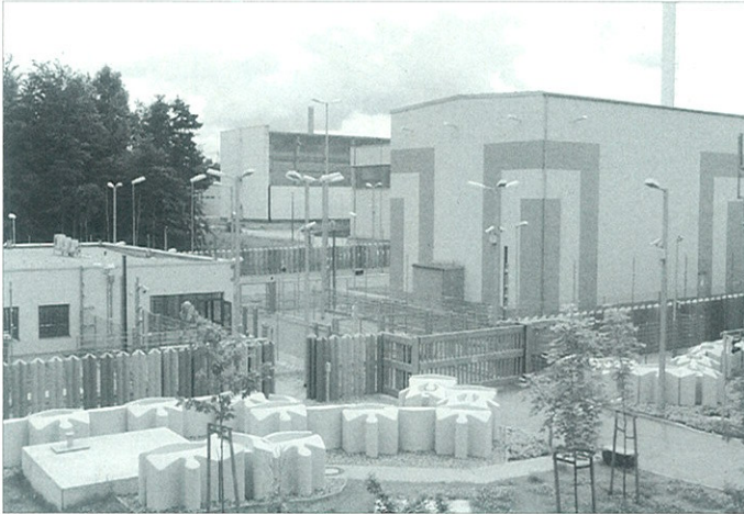
Die Schaffung einer Einrichtung zur Sicherung und Entsorgung von Kernmaterial Rossendorf (EKR) war die wichtigste Sicherungsmaßnahme des VKTA. Inbetriebnahme: 1999
