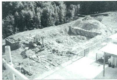
Stilllegung von sonstigen Anlagen der ehemaligen kerntechnischen Infrastruktur. Die spezielle Kanalisation ist stillgelegt, der Zivil- schutzbunker wurde abgerissen.
