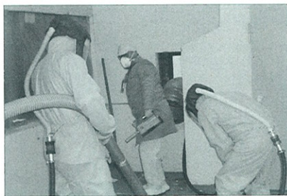
Stilllegung der Isotopenproduktion: Mit der Stilllegung wurde begonnen, das Tresorhaus und eine Reihe von Labors wurden abgebaut.
