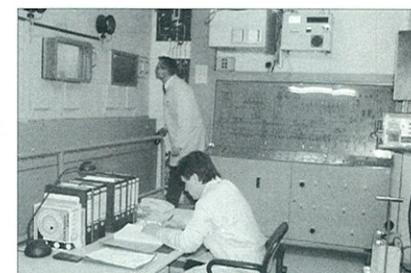
Stilllegung des AMOR-Komplexes: Der Anlagenkomplex ist frei von Kernmaterial, die erste Anlage ist vollständig abgebaut.
