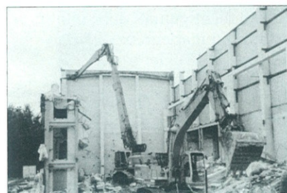
Stilllegung und Rückbau des Urantechnikums (UT) wurde im Jahr 2000 vollständig abgebrochen.
