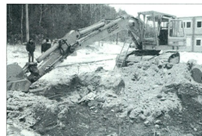
Stilllegung des Rossendorfer Forschungsreaktors (RFR): Die Brennelemente sind aus der Anlage entfernt, der zweite Kühlkreislauf ist abgebrochen (Foto).
