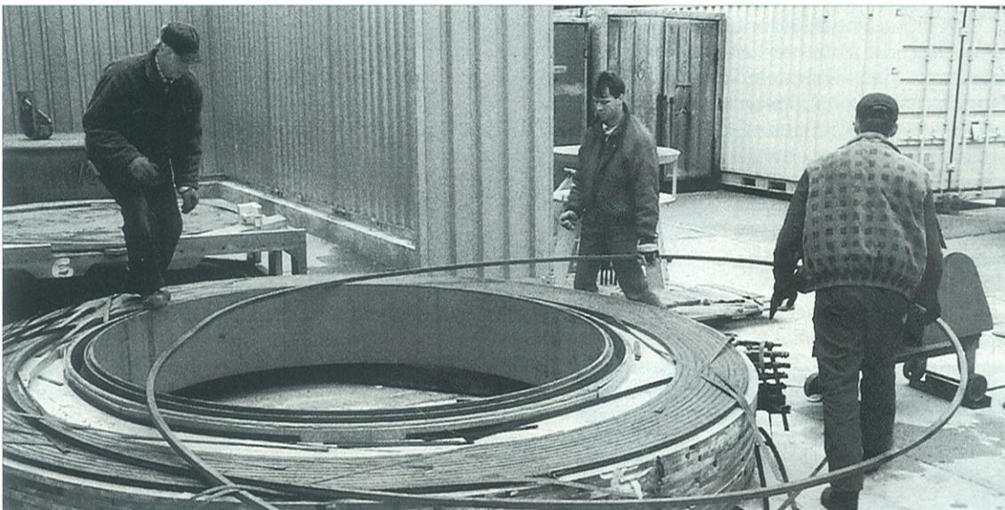
Demontage von Bauteilen eines Zyklotrons nach der radiologischen Freigabe zur Abgabe als Schrott zur uneingeschränkten Weiterverwertung.
