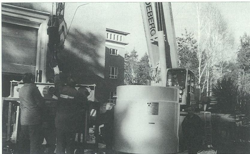
Am 16. Januar 1997 kam der erste Castor-Behälter nach Rossendorf. An ihm soll die Umladung der Brennelemente aus dem Wasserlager durch eine mobile Station »kalt« erprobt werden. Foto: VKTA
