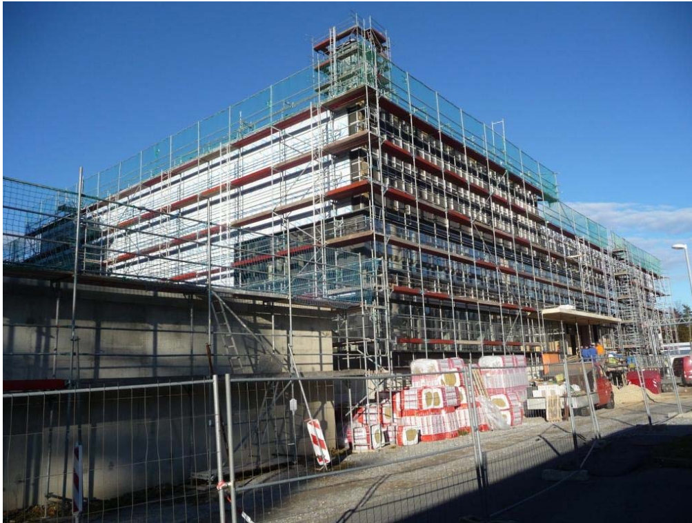
Abb.: 5.1: ZRT-Baustelle Ende 2014; im Vordergrund links der Zyklotron- bunker
