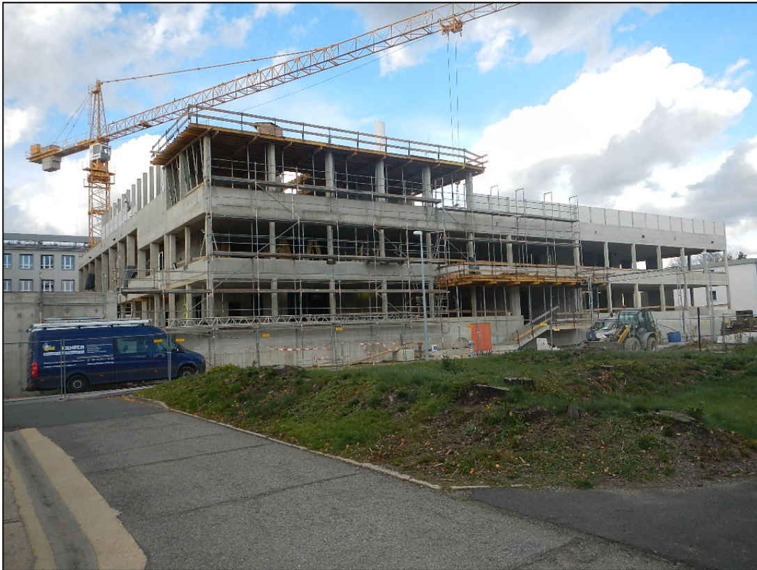
Abb.: 5.1: ZRT-Baustelle im Dezember 2013
