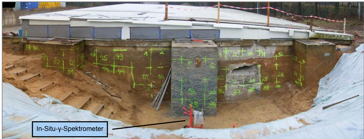
Abbildung 8.1: Baugrube an der NW-Seite des Gebäudes 99 mit wetterfest verpacktem In-situ-Gamma- spektrometer
