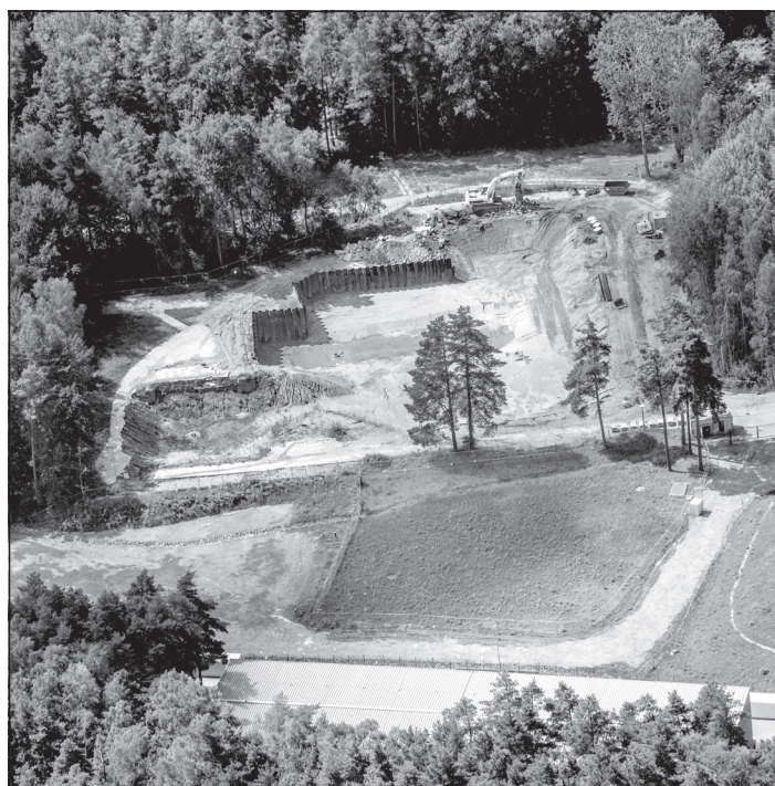
Bild 3: Luftaufnahme der Baugrube RFR aus 2016
