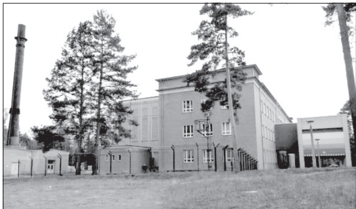
Bild 2: Gebäudekomplex mit Filterhaus, Reaktorhalle, Labortrakt und neuer Reaktorwarte (v. l. n. r.)
